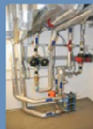
Bombas de calor geotérmicas,
