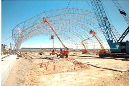
Dependiendo del diseño, existen varios tipos de cerchas. En la figura de la derecha tienes algunos de los tipos de cercha más utilizados. A la izquierda, un conjunto de cerchas en forma de arco que servirán para soportar la cubierta de un hangar para aviones.
