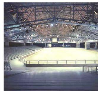
La razón para que todos los huecos de la estructura sean triangulares es que el triángulo es una figura que no se puede deformar aunque los puntos de unión estén articulados.
