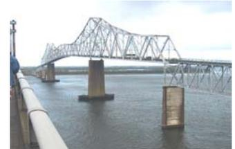
Los pilares están sometidos a un esfuerzo de compresión porque el puente que soportan tiende a \_\_\_\_\_
