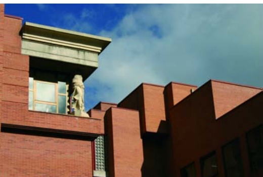
AMPLIACIÓN DE LA ESCUELA DE ARQUITECTURA (Valladolid, 1987-90). Antonio Fdez. Alba
