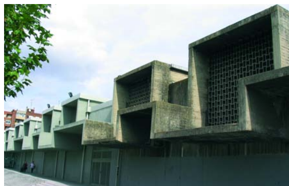
ANTIGUO MERCADO CENTRAL (Valladolid, 1965-66) Juan Agulló Villahermosa
