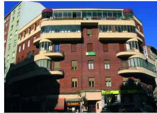
EDIFICIO DE VIVIENDAS (León), 1938. Ramón Cañas y del Río y Juan Torbado Franco
