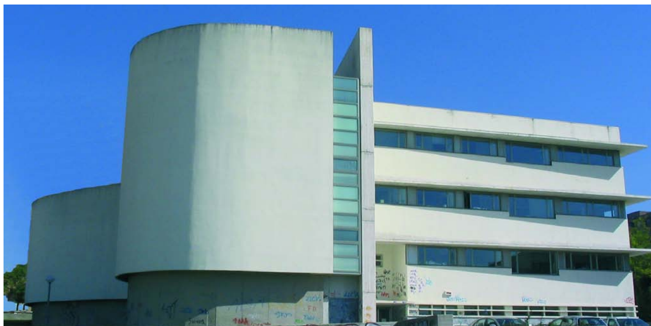
CENTRO SANITARIO DE PARQUESOL, (Valladolid, 1994-96). Enrique de Teresa y J. José Echeverría
