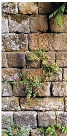
Alzado interior del estribo de **Ponte Freixo** (Ourense) **con aparejo a soga y tizón.**
