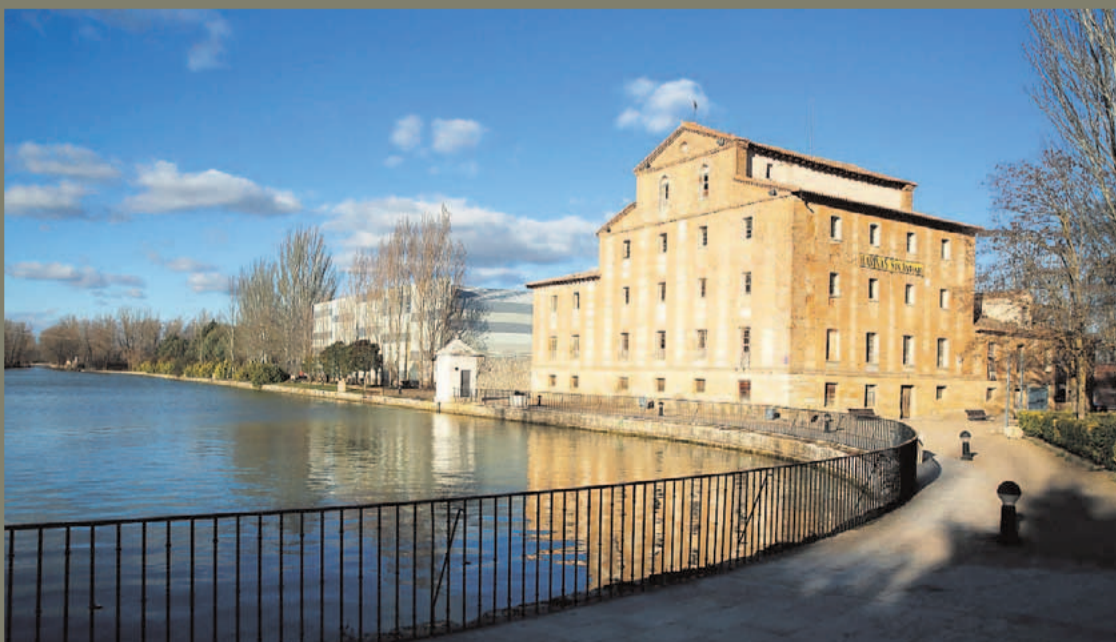
▲ Dársena del Canal en Medina de Rioseco, con la fábrica de harinas de San Antonio a la derecha.
