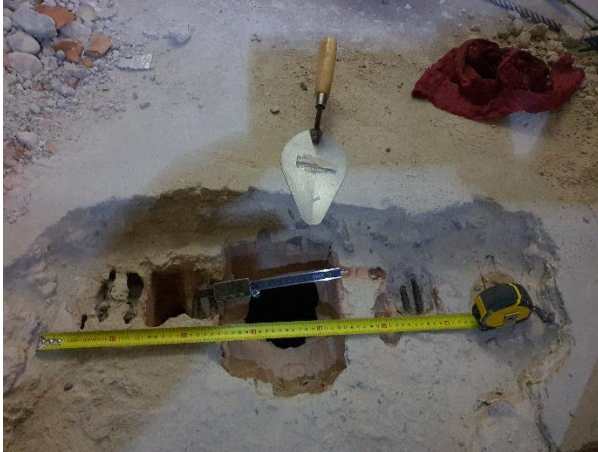
Foto 1. Vista general de la cata en la cara superior.
