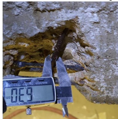
Foto 4. Medida del diámetro de la armadura de cortante
