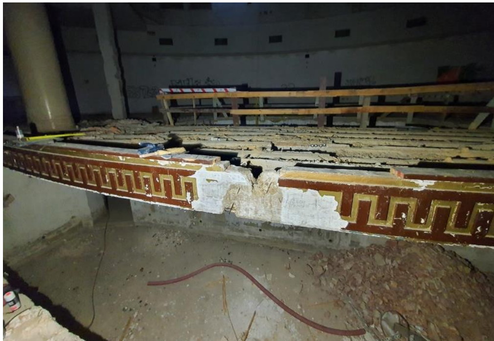
FOTO 76 – Vista general de la cata realizada en el zuncho de borde de la losa del escenario.
