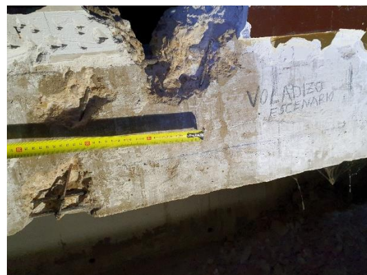
Foto 6. Medida de la distancia entre estribos.
