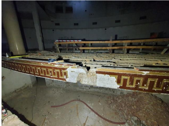
Foto 1. Vista general de la cata
