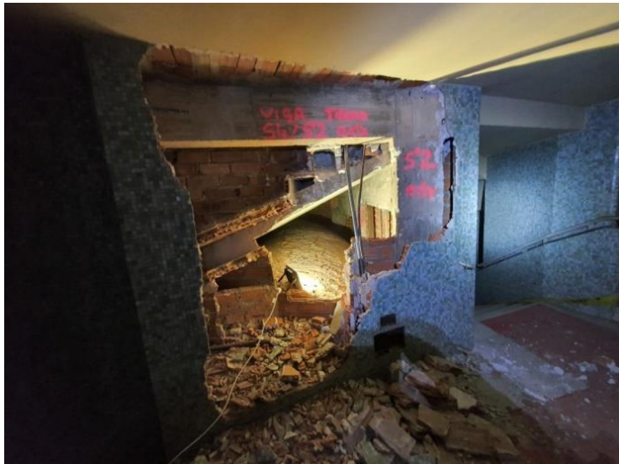
FOTO 102 – Vista general de la losa inclinada de la platea alta, bajo ella se encuentra la bóveda de cañón de la P. Baja.
