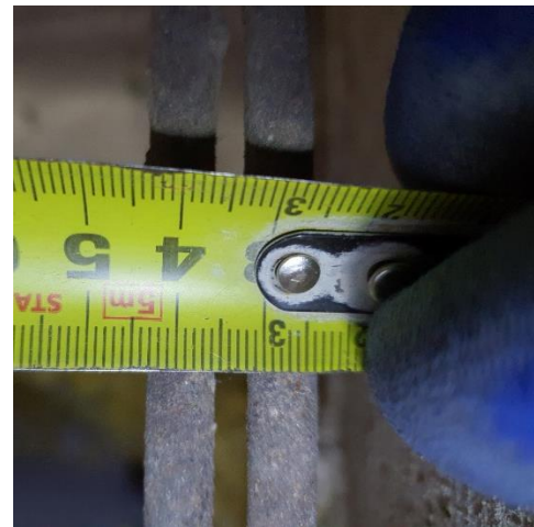
Foto 4. Medida del diámetro de las barras
