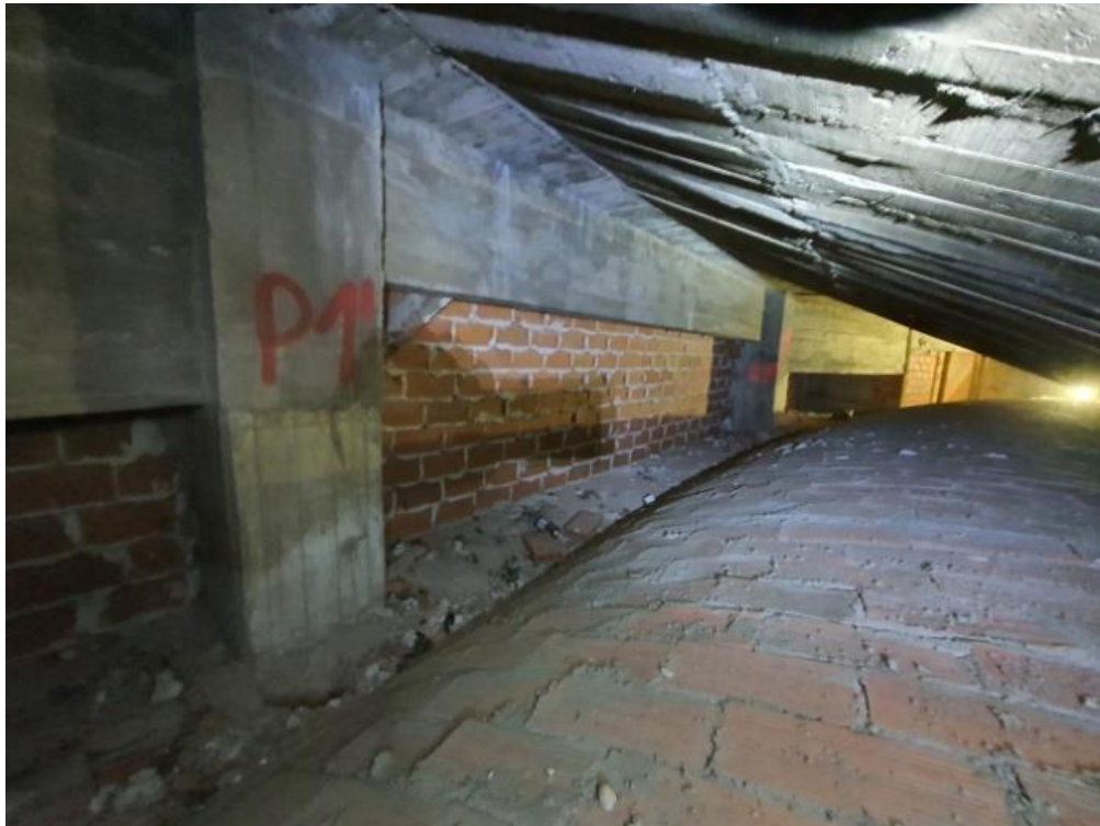
FOTO 104 – Vista general de la zona existente entre la platea alta y la bóveda de cañón donde se observa la estructura de hormigón existente.
