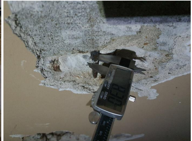
Foto 2. Armadura de positivos.
