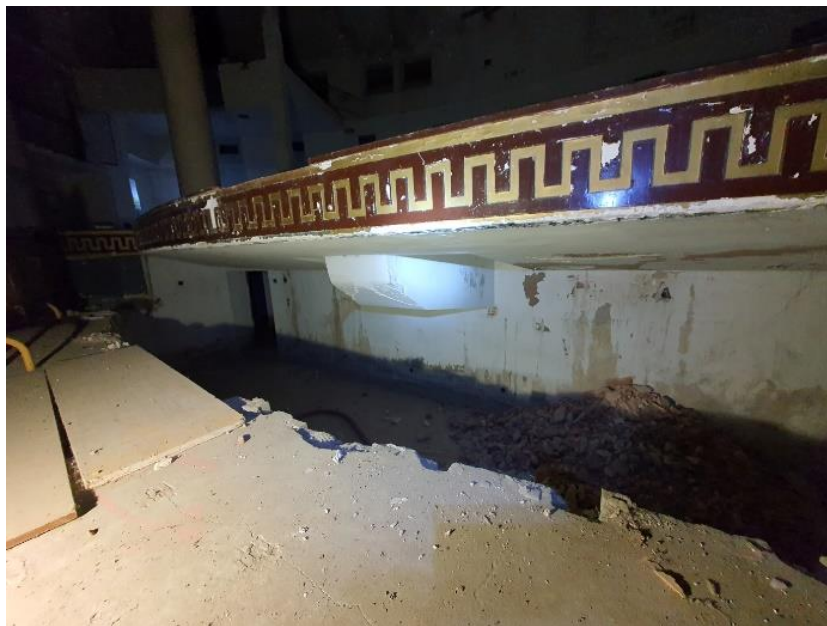
FOTO 71 – Forjado frontal del escenario que se encuentra en voladizo.
