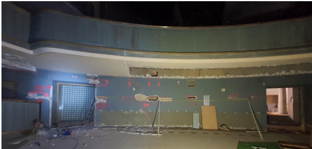
FOTO 77 – Vista general del muro curvo.
