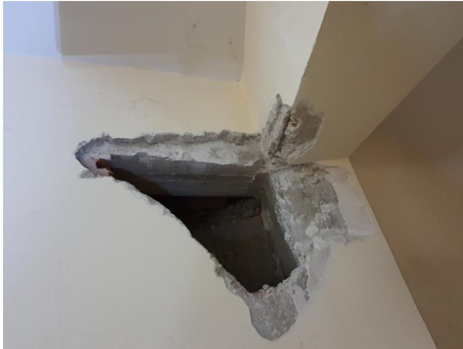
FOTO 116 – Detalle de la cata realizada en el encuentro del cordón superior y montante vertical de la cercha 1 para ver la conexión.
