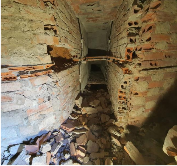
FOTO 5 – Interior de la galería como contención del relleno de tierras.
