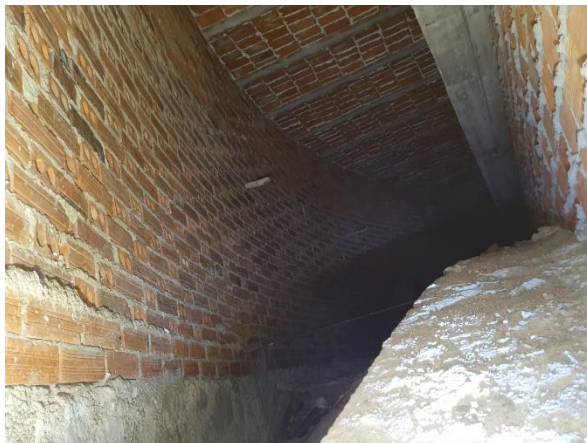
Foto 3: Vista general donde se observa a la derecha una viga de hormigón, y forjado unidireccional de la cúpula central.
