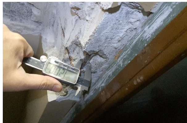
Foto 5. Medición de la armadura inferior.
