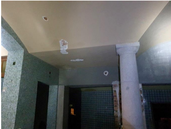
Foto 1. Vista general de la cata desde la zona del vestíbulo.
