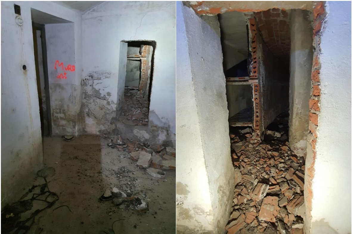
FOTOS 1 y 2 - Entrada a la galería que se encuentra entre los dos muros concéntricos.
