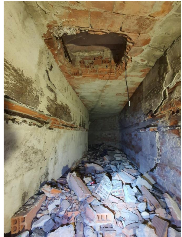
FOTO 8 - Imagen desde la cara inferior de la cata 10 INC:
