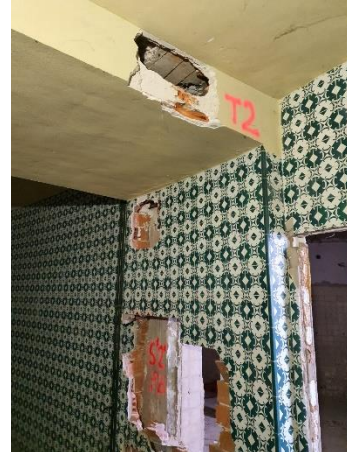
Foto 2. Detalle de la cata desde la cara inferior
