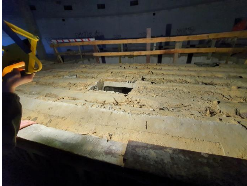
FOTO 72 – Vista de la cara superior del forjado en voladizo del escenario.
