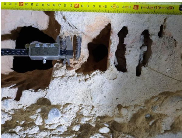
Foto 3. Armadura de negativos.
