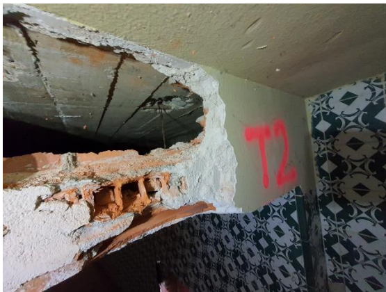
Foto 3. Apertura en el falso techo continuo.
