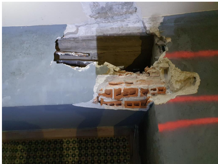
Foto 1-2: Comprobación de la viga de hormigón.
