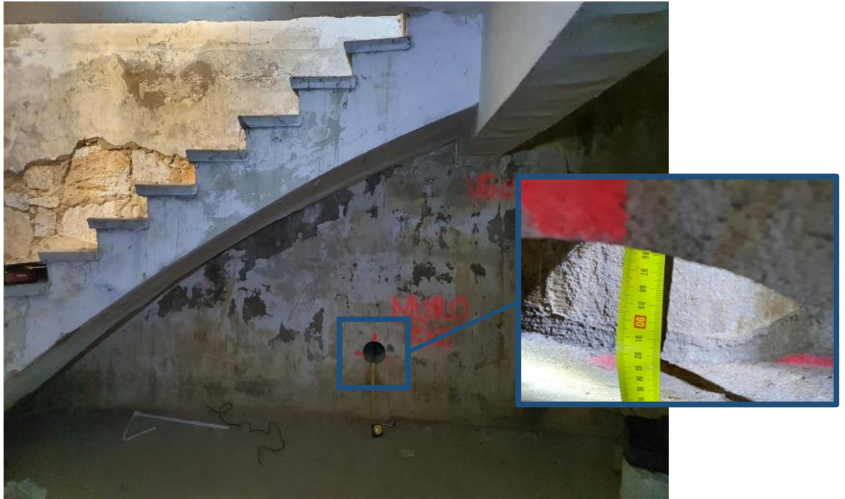
FOTOS 23 y 24 – Vista general y detalle de la medición y caracterización del muro de sótano en el taladro 2 de Intemac.
