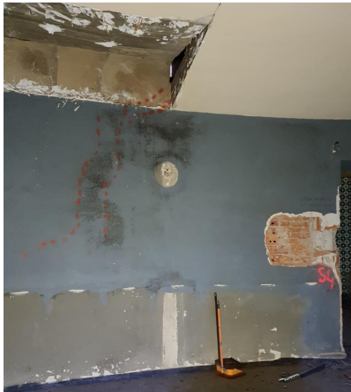
FOTO 84-85 – Vista general y detalle de cata para localizar pilares de hormigón embebidos en el muro curvo.
