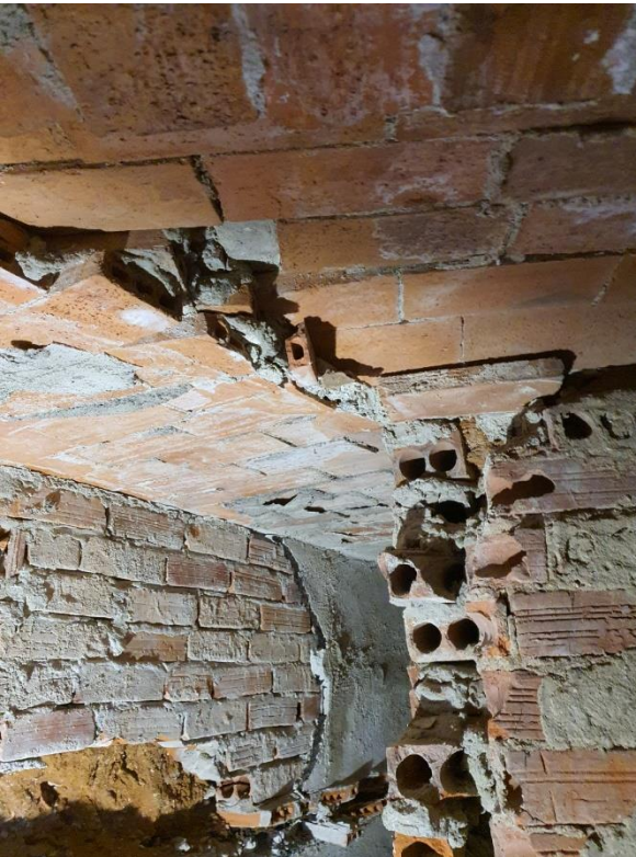
FOTO 7 - Cara inferior del forjado de la galería. Detalle del encuentro entre ladrillos
