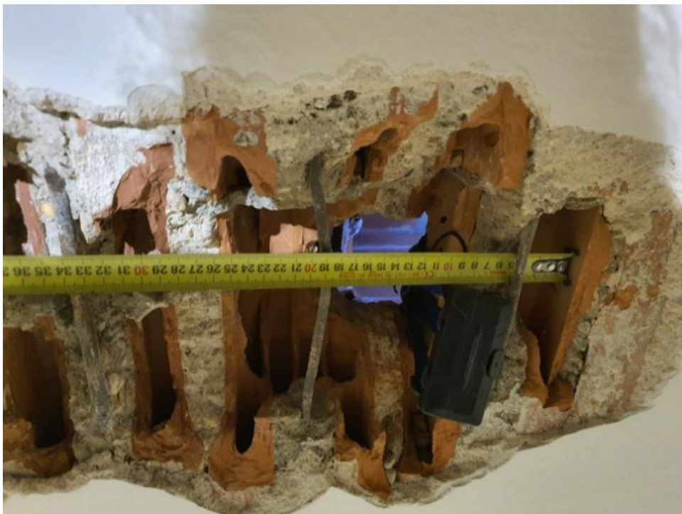
FOTO 119 – Detalle de cata realizada para caracterizar el forjado horizontal, donde se atravesó para ver el apoyo del forjado de cubierta.
