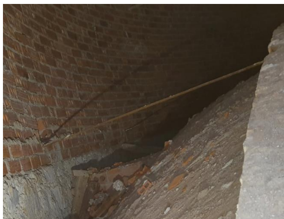
Foto 5: Detalle de tirante metálico .
