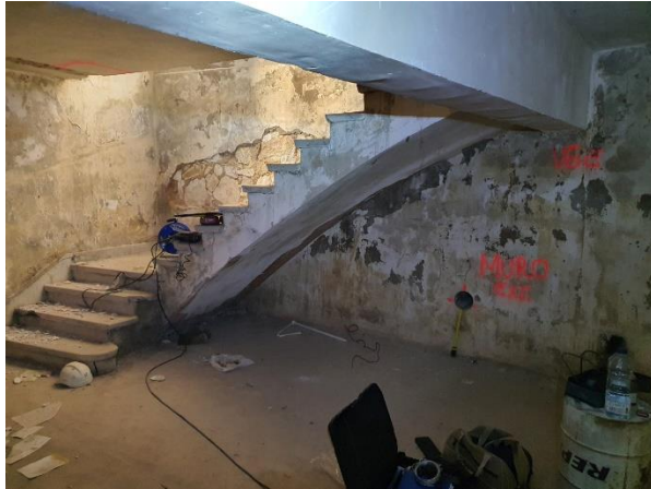
Foto 1. Vista general de la cata en la cara inferior.
