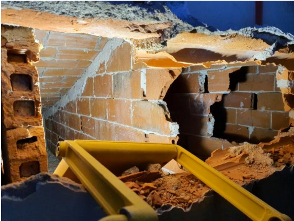
FOTO 118 – Detalle donde se observan tabiques conejeros dispuestos cada 50 cm aproximadamente, para recibir el apoyo del forjado inclinado.
