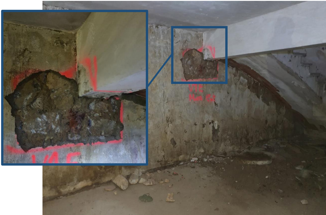
FOTOS 42 y 43 – Vista general y de detalle del encuentro entre la viga del forjado del escenario y el muro de mampostería. Viga V1E
