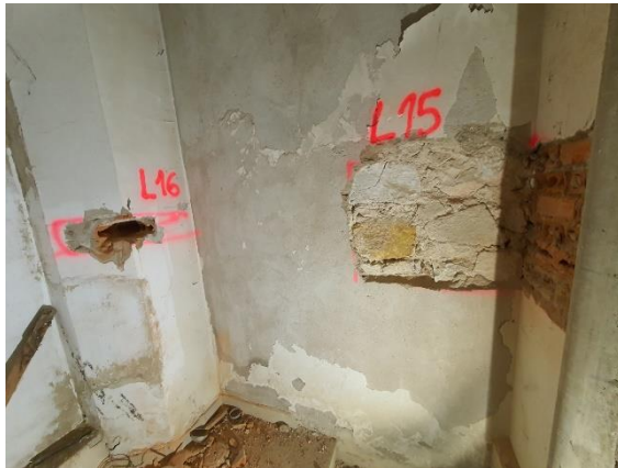
Foto 1. Rozas en muro para determinar la composición de los diferentes tramos de muro.
