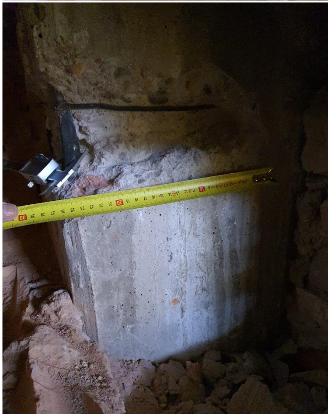
Foto 2. Medición del diámetro de la armadura del pilar. Se estima que hay dos armaduras en la cara Y del pilar
