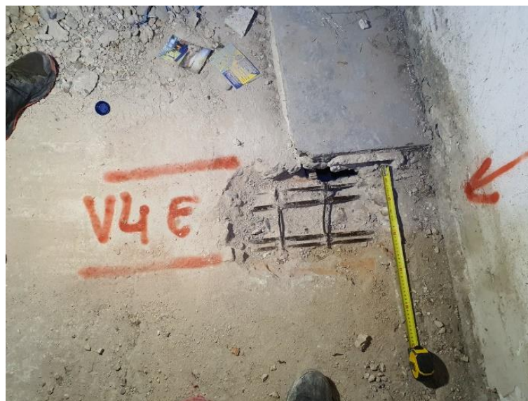
FOTO 59 – Cata 10 de Intemac. Cata de negativos junto al apoyo de la viga en el muro de mampostería
