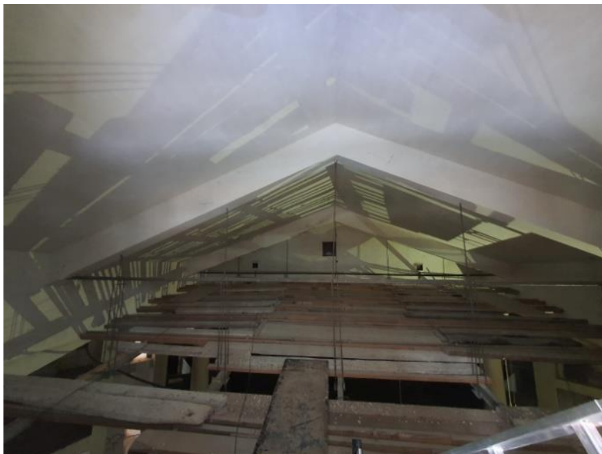
FOTO 121 – Vista general del forjado inclinado de la cubierta, que se apoya sobre vigas de cuelgue, de las cuales cuelga la estructura del peine sobre el escenario.
