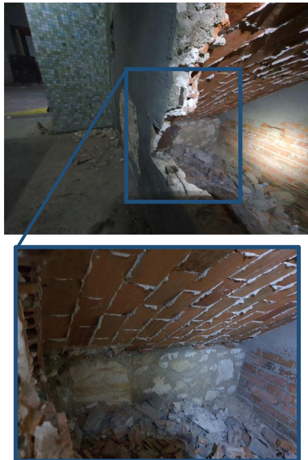
FOTO 94-95 – Vista general y detalle de la cata realizada en el arranque de la escalera, donde se observa el arranque de la misma sobre muro de mampostería.
