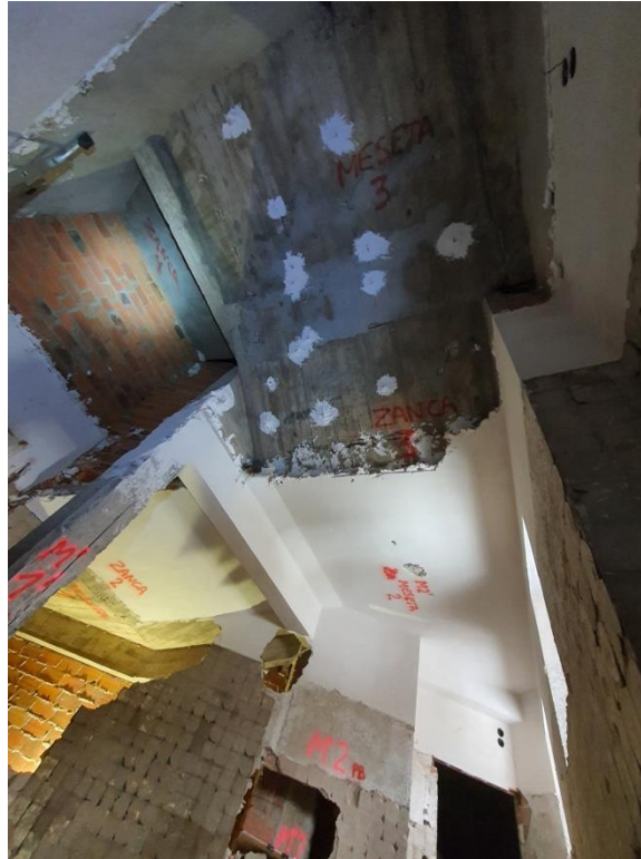
FOTO 90 – Vista general de la cara inferior de los diferentes tramos de la losa de la escalera
