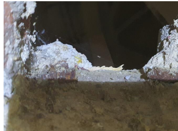
Foto 4. Detalle de la armadura longitudinal de la viga cortada.
