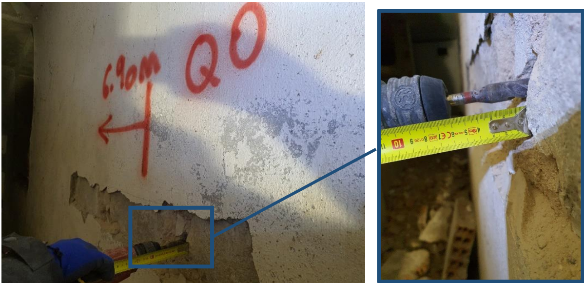
FOTOS 28 y 29 – Taladro realizado en muro de sótano para determinar su espesor. En este caso es el taladro 1 realizado por INCOSUMA.
