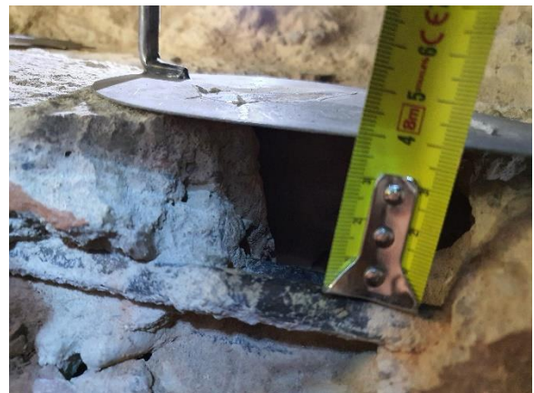
Foto 6. Recubrimiento armadura negativos
