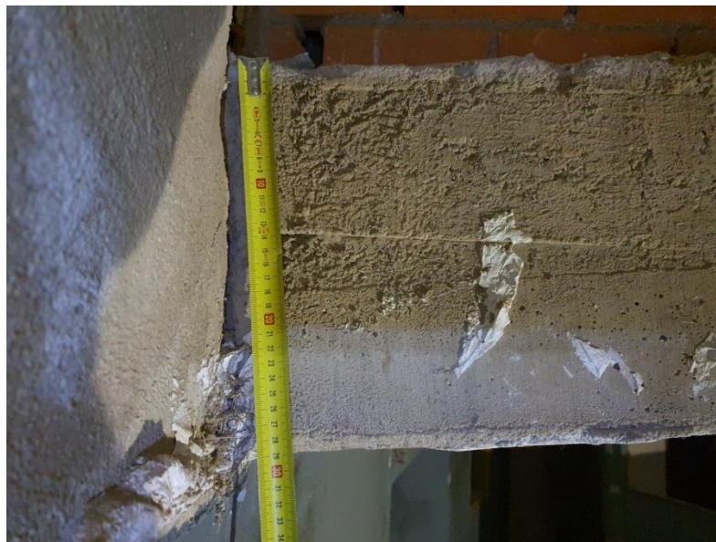
FOTO 98-99-100 – Vista general y detalles de la medida del espesor de la losa de canto variable.
