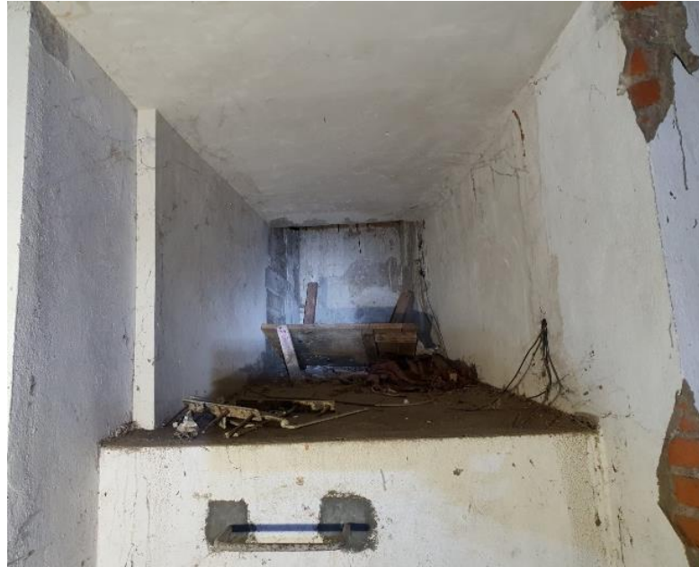
FOTO 75 – Vista del interior del hueco que se encuentra en el escenario.
