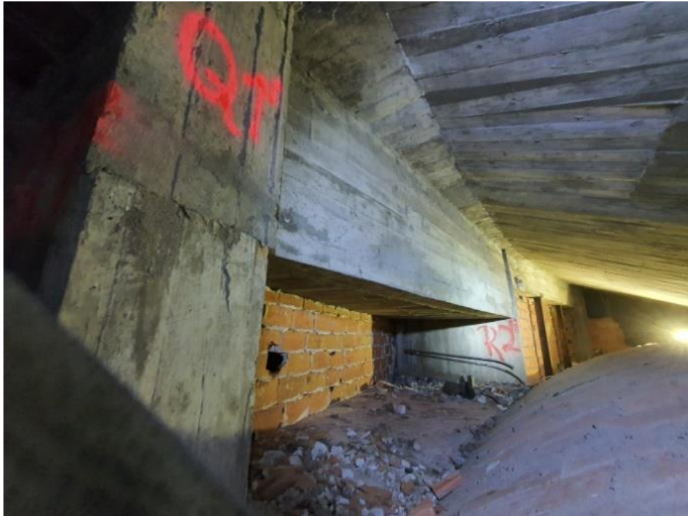
FOTO 103 – Vista general de la cara inferior del contrapeso de la platea alta.
