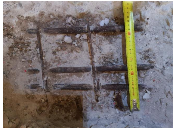
Foto 2. Medida aproximada del ancho de la viga.
