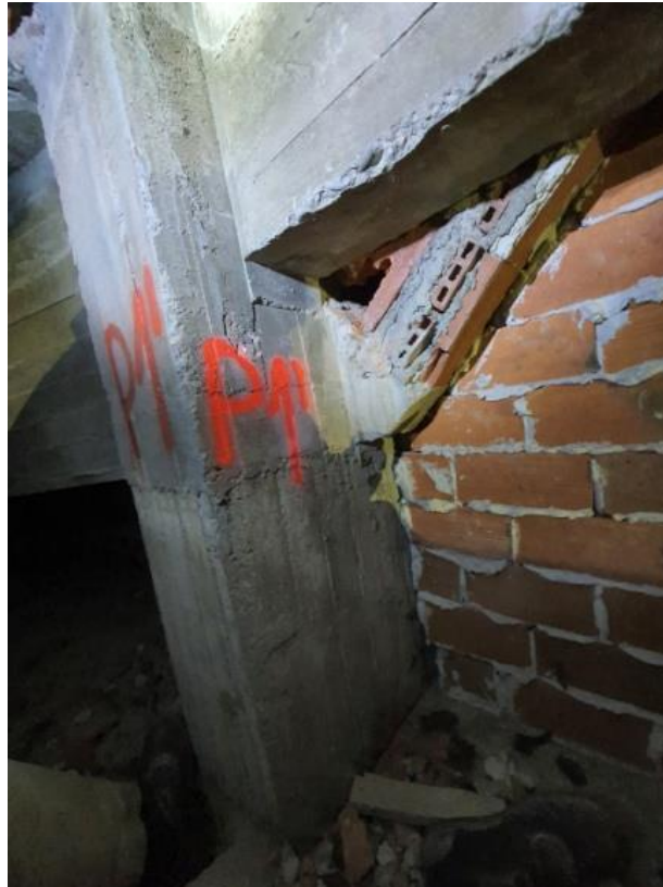
FOTO 105 – Detalle del apoyo de la bóveda que pilar de hormigón.
