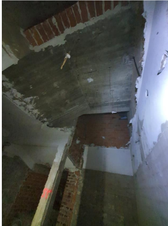
FOTO 93 – Vista general de la cara inferior de la losa de la escalera.
