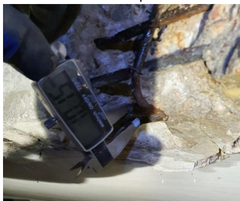
Foto 5. Medida del diámetro de la armadura inferior
