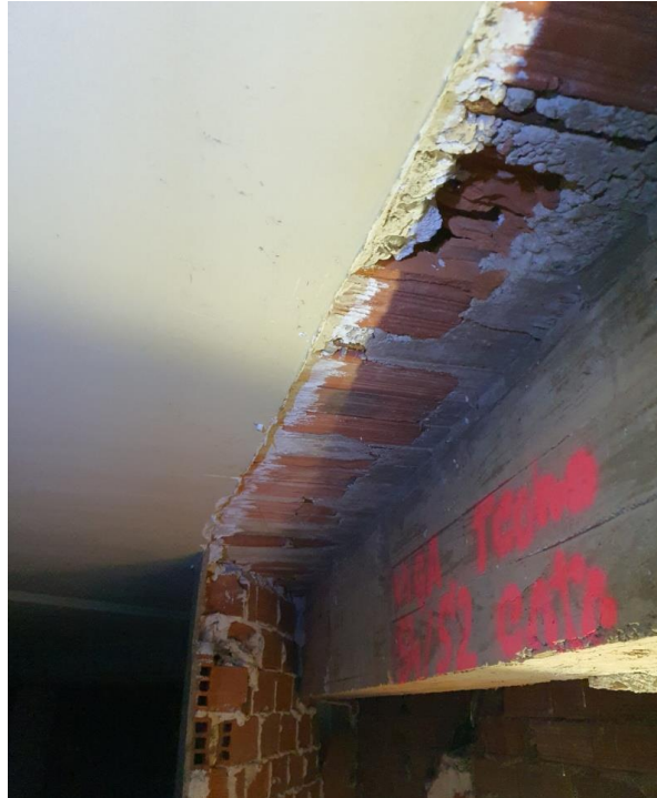
FOTO 110 – Detalle del forjado unidireccional en la cara inferior del forjado de 1ª Planta, en la zona cercana a las escaleras.
