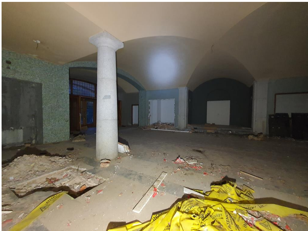
FOTO 109 – Vista general de las bóvedas de cañón en la zona del vestíbulo.
