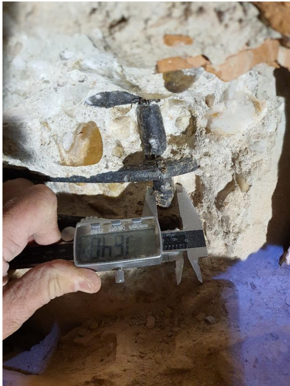
Foto 1. Medición del diámetro de la armadura del pilar
