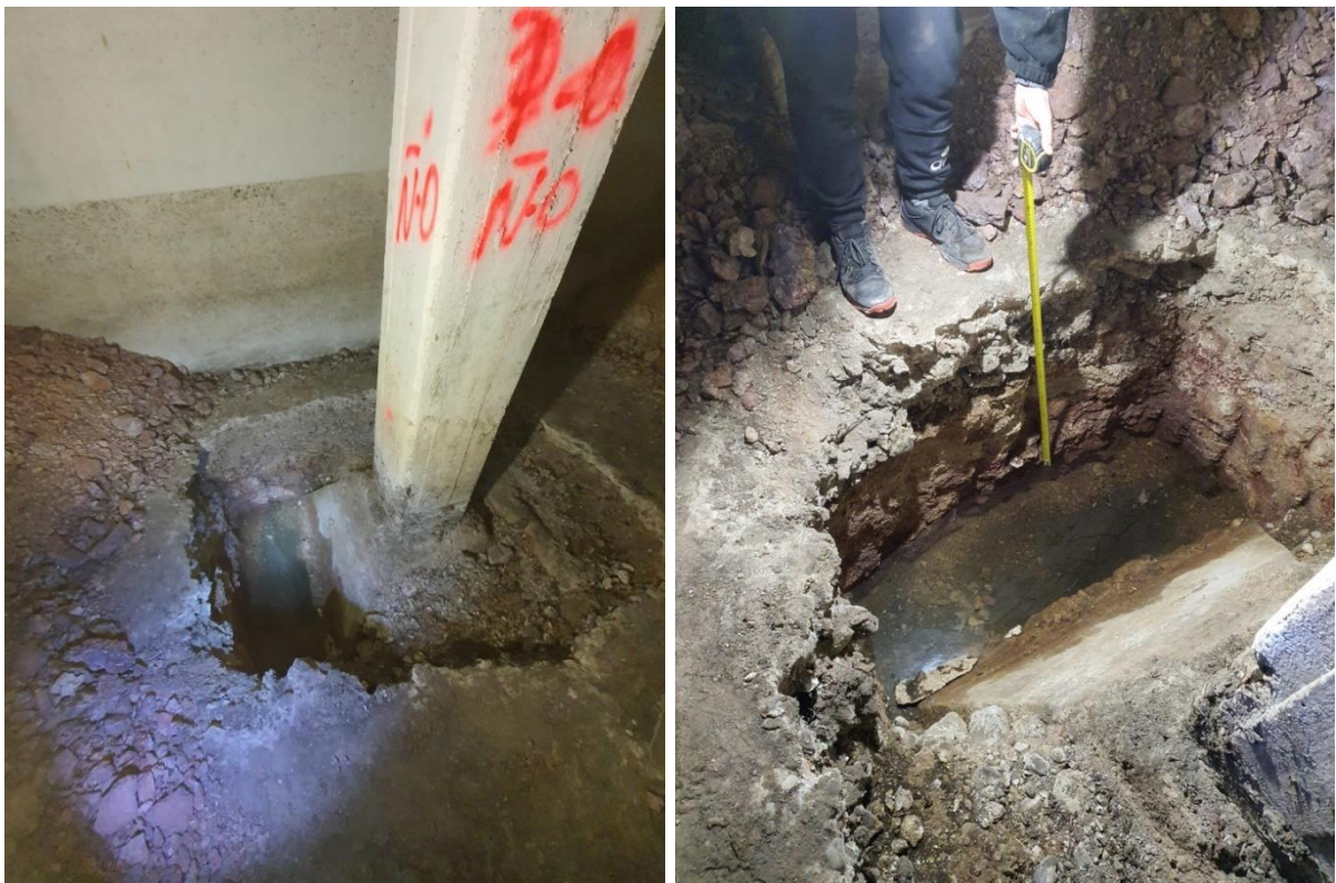
FOTO 40 y 41 – Cata en el pilar Ñ 0 de Intemac.
