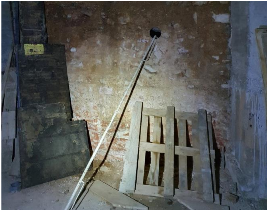
FOTO 25 – Vista general del taladro 2 de Intemac por la cara exterior del muro.
