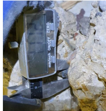
Foto 2. Medida del diámetro de la armadura longitudinal
