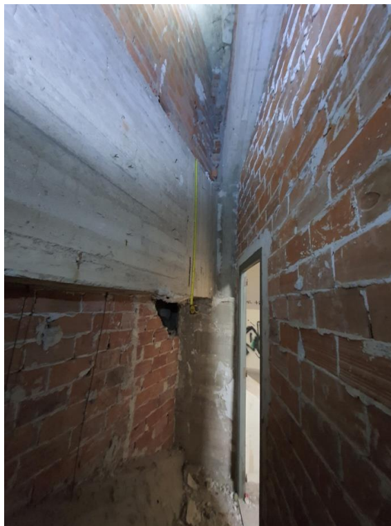
FOTO 115 – Vista general del encuentro de la viga curva de gran canto, la viga horizontal y el montante vertical de la cercha 1.
