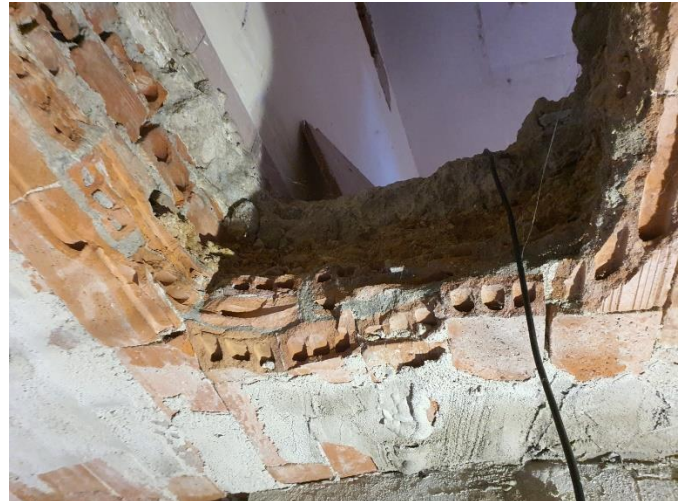
Foto 2. Detalle de la cata desde la cara inferior
