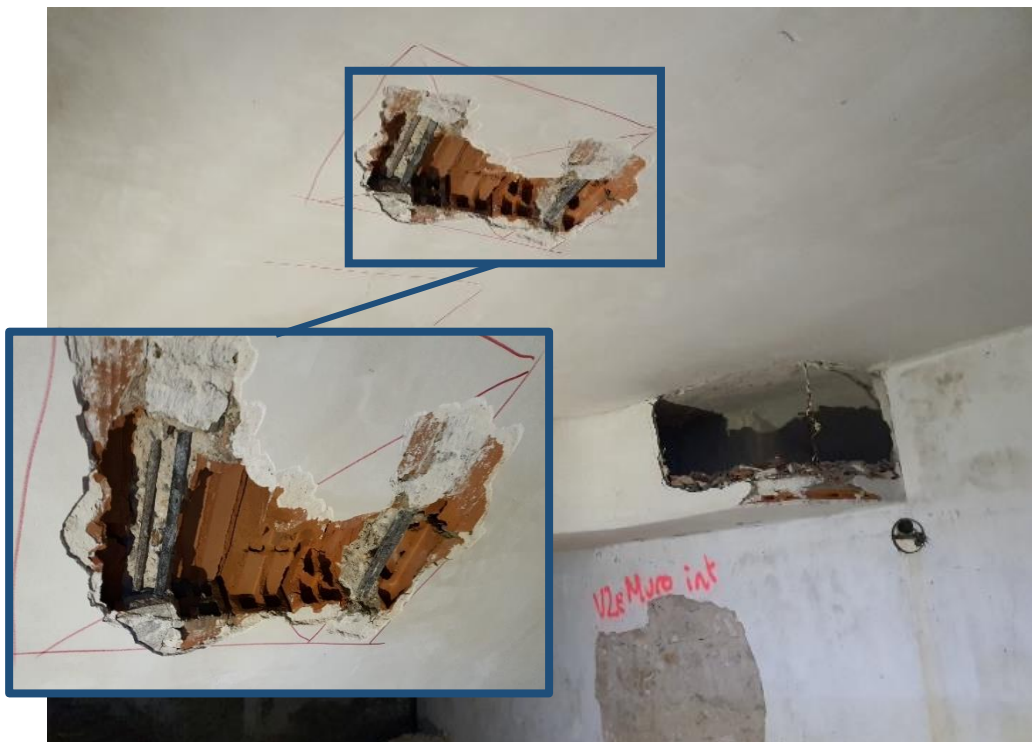
FOTO 44 y 45 – Cata 2 de Intermac en el forjado de escenario.
