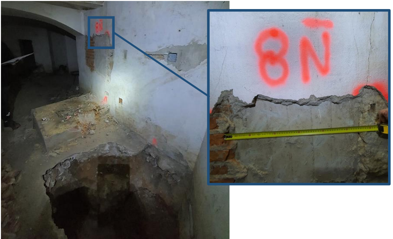
FOTOS 35 y 36 – Pilar 8 Ñ de hormigón armado embebido en el muro de sótano.
