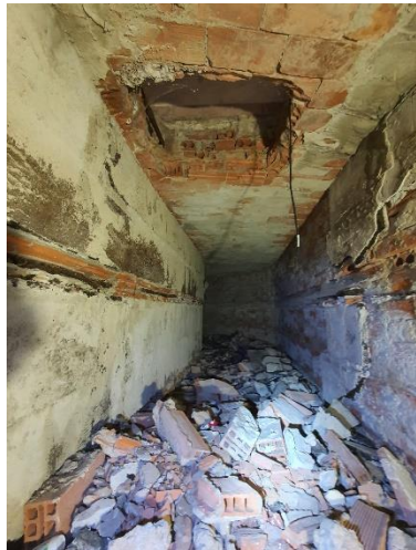
Foto 1. Vista general de la cata desde la galería en el sótano.
