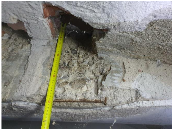
Foto 3. Medida del cuelgue de la viga
