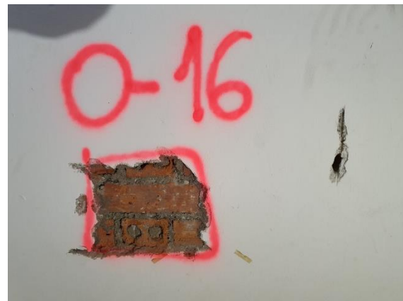
Foto 2. Roza donde se observa fábrica de ladrillo resistente.
