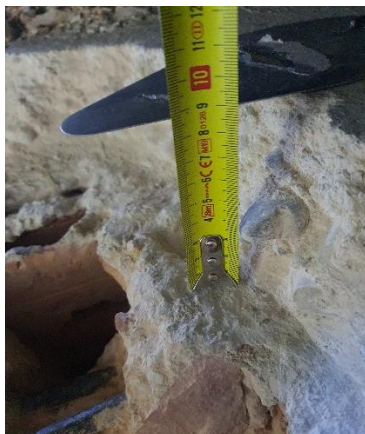
Foto 5. Espesor del solado
