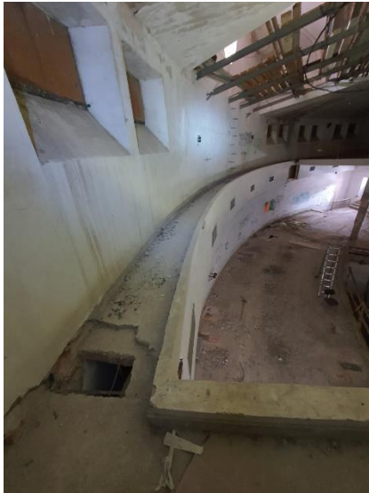
Foto 1. Vista general de la cata en la zona del escenario.
