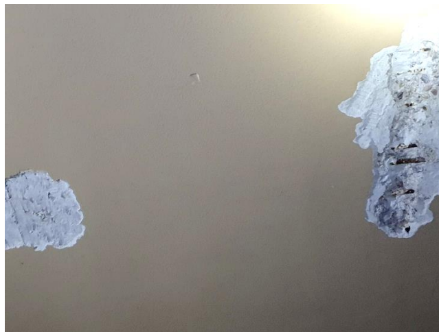
Foto 3. Se observan 3 armaduras en la cara inferior de la losa.
