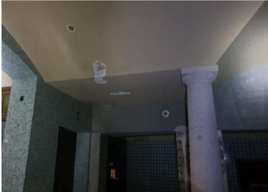
FOTO 101 – Vista general del contrapeso de la losa inclinada.
