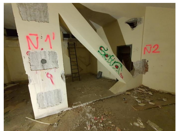
Foto 6: Vista general del Taladro 16.
