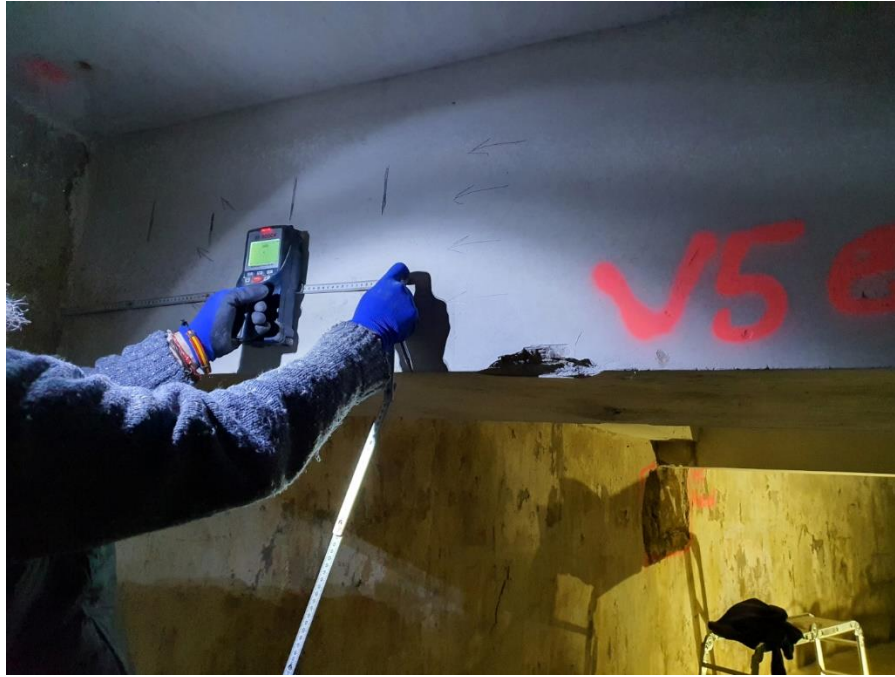
FOTO 61 – Pachometría realizada en una de las vigas de canto del escenario. Se comprobaron la distancia entre los estribos junto al apoyo de la viga en el muro.
