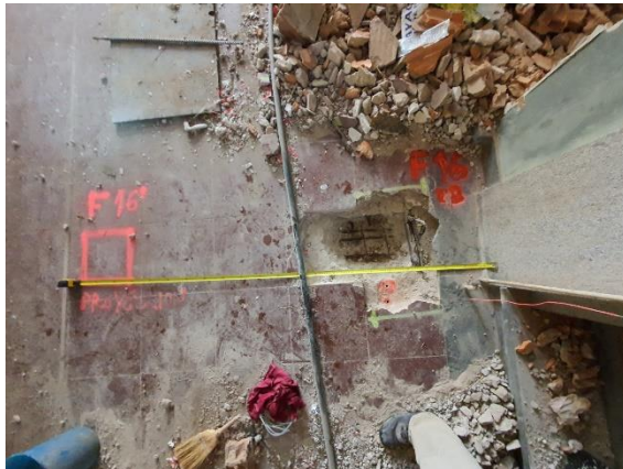
Foto 1. Vista general de la cata
