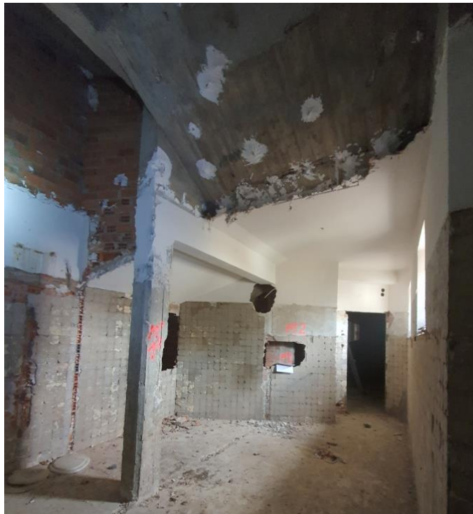
FOTO 89 – Vista general de la zona de las escaleras, donde se observa la estructura de apoyo de la losa de escalera y zancas.
