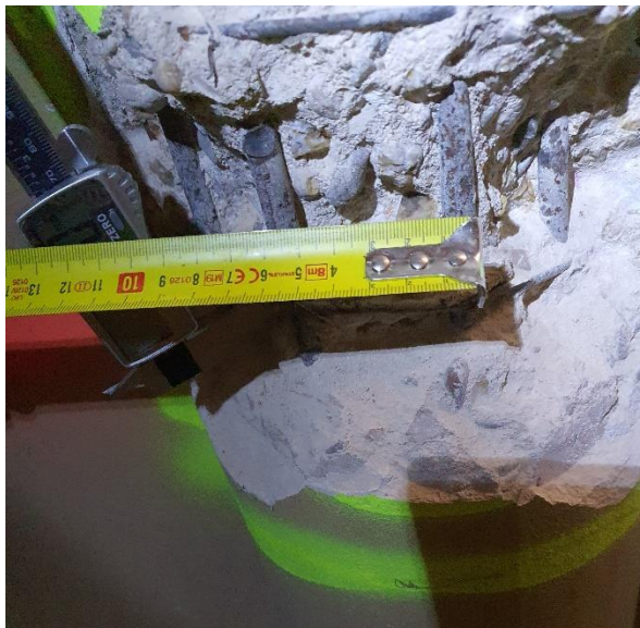
Foto 3. Distancia entre armaduras
