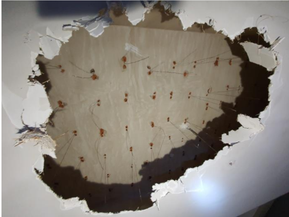
FOTO 114 – Vista general donde se observa la existencia de forjado unidireccional.
