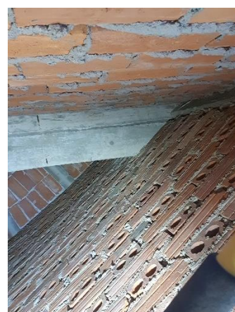
Foto 6: Detalle de la viga de cuelgue
