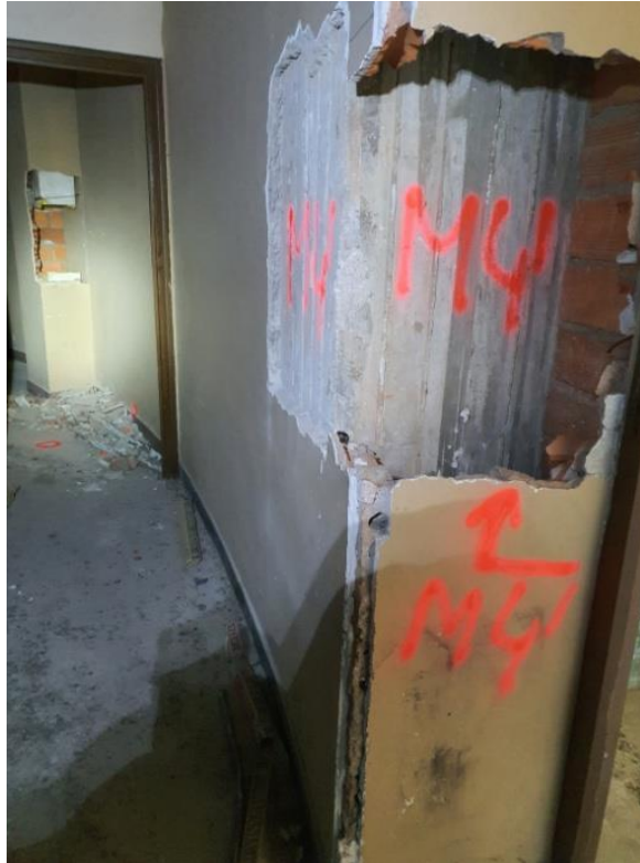
FOTO 112 – Detalle de cata realizada para detectar la existencia del pilar de hormigón.
