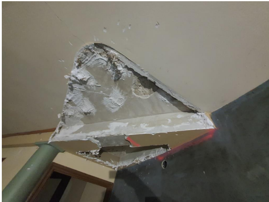
Foto 1-2-3: Comprobación de la viga de hormigón.
