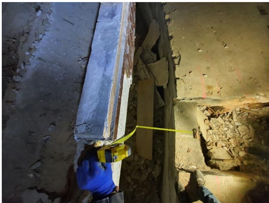
FOTO 18 – Medición y caracterización del muro del foso en la cata 8 INC.
