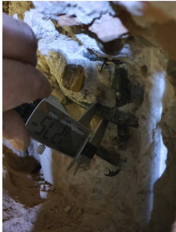
Foto 2. Medición de los cercos del pilar
