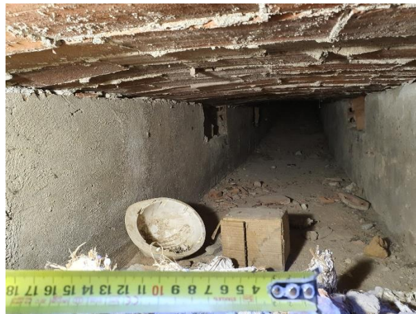
Foto 3. Vista general de las galerías bajo la platea principal.
