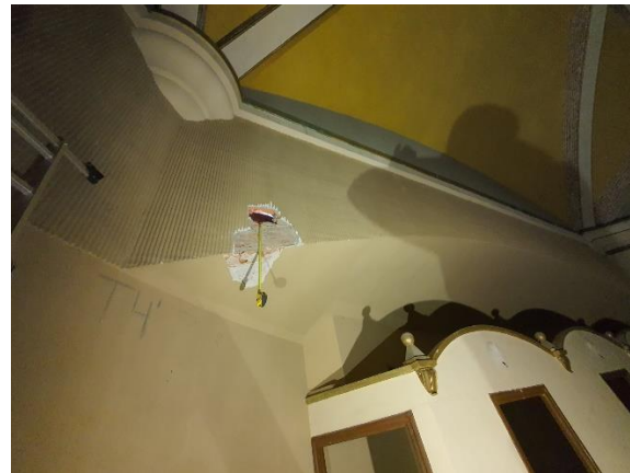
Foto 2: Vista general de la cata realizada
