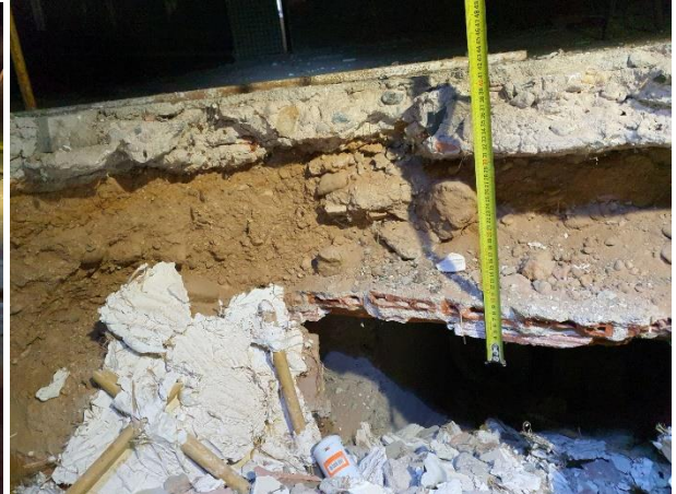
Foto 2. Medida del espesor de la solera.
