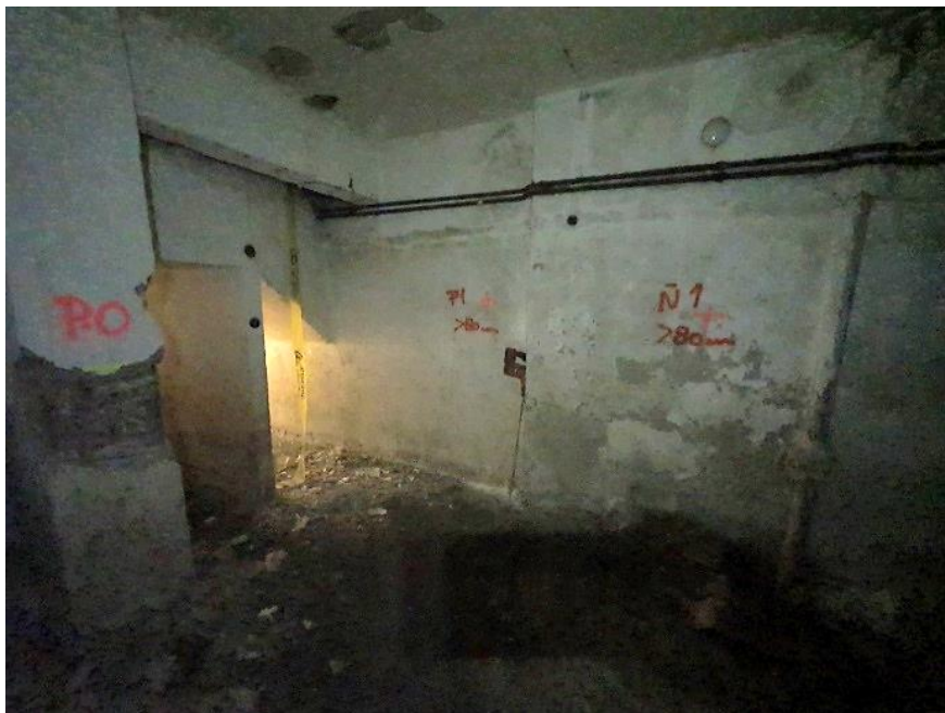
FOTOS 30 y 31 – Taladros realizados en muros de sótano para determinar su espesor. En este caso son los taladros 2 y 3 realizados por INCOSUMA.
