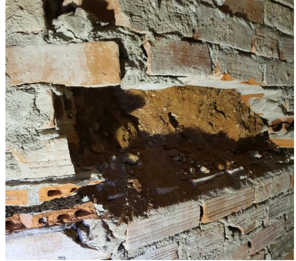
FOTO 6 – Muro de ladrillo hueco que sirve como contención del relleno de tierras.
