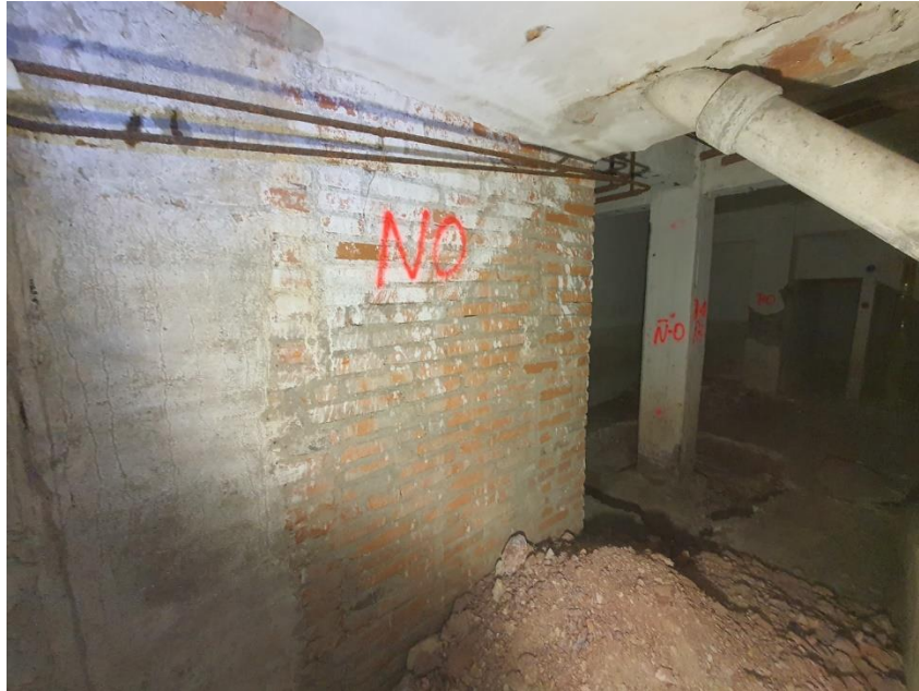
FOTO 39 – Vista general de la cata 59 de Intemac
