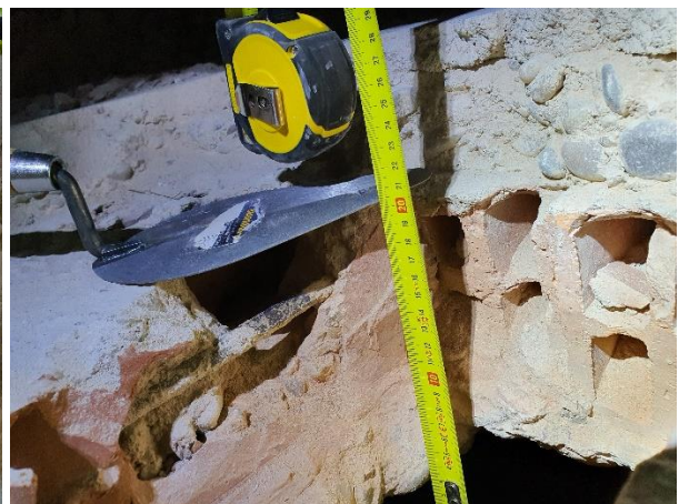
Foto 4. Medición del canto del forjado
