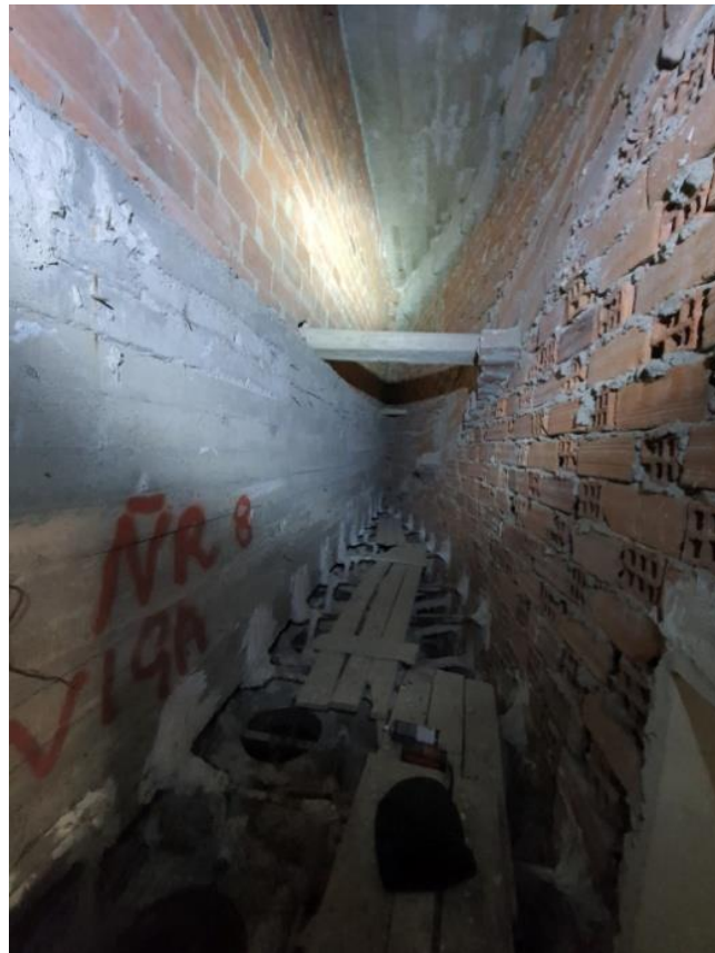
FOTO 122 – Vista general donde se observa la viga curva de gran canto, la viga horizontal y el cierre superior por medio de una losa de hormigón.
