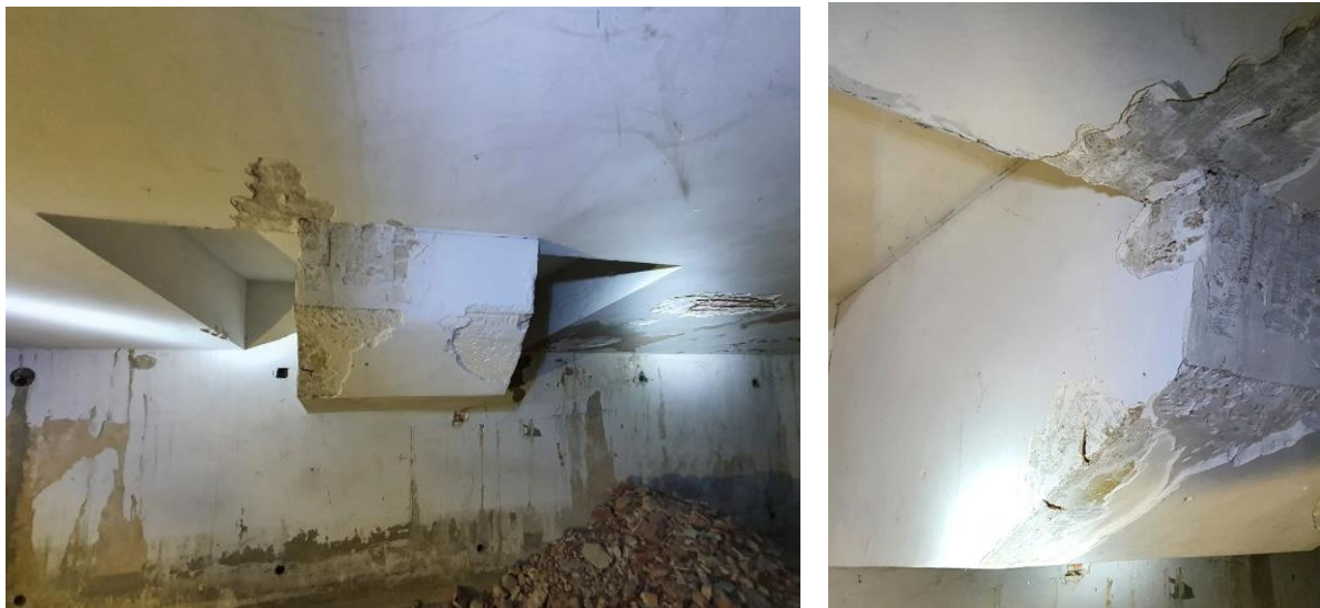
FOTOS 73 y 74 – Vista de la cara inferior del forjado del voladizo donde se observa un elemento de hormigón que da forma al hueco situado en el escenario.
