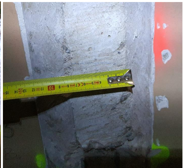
Foto 4. Medición de una de las caras del pilar
