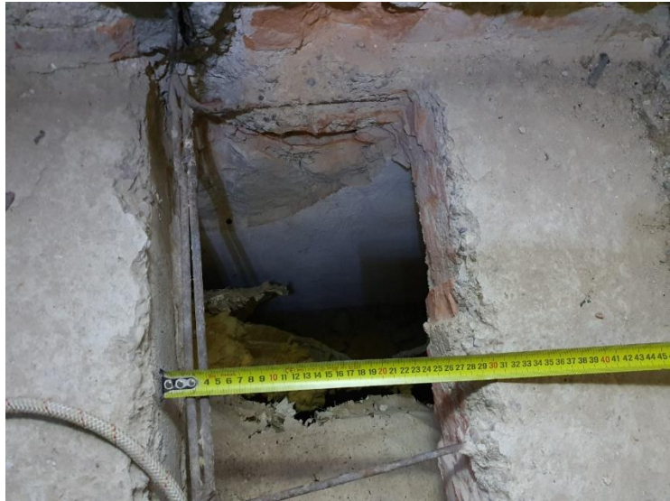
Foto 2. Detalle de la cata desde la cara superior
