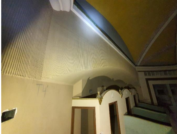
Foto 1: Vista general de la bóveda.
