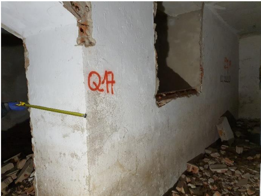
FOTO 34 – Caracterización de muro de sótano. Taladro 4 INC.
