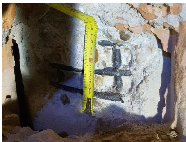
Foto 3. Medición de la distancia entre cercos.
