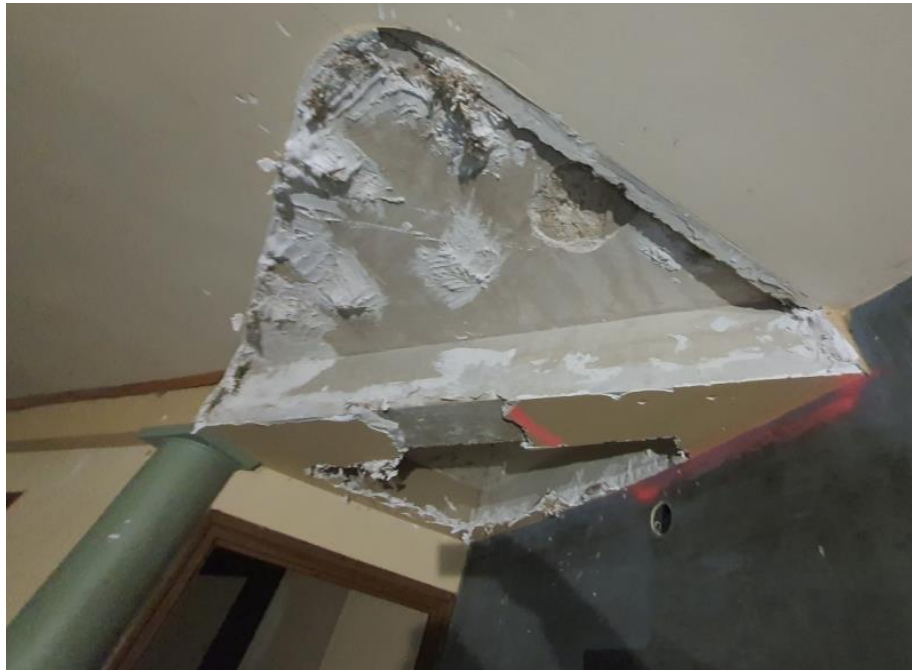
FOTO 96 – Vista general de la cata realizada para determinar la existencia de la viga de hormigón.
