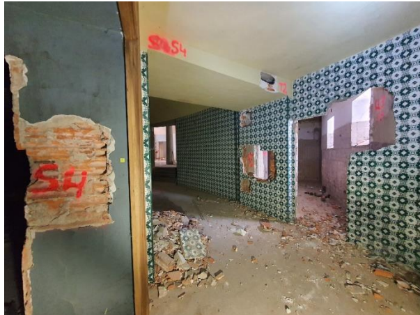
Foto 1. Vista general de la cata desde el pasillo de la curva.
