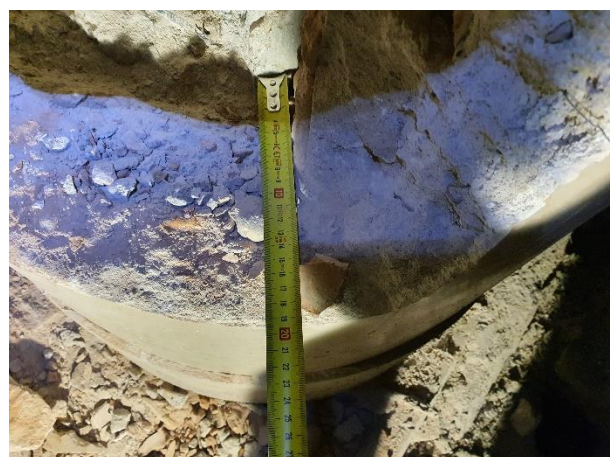
Foto 4. Revestimiento del pilar por ladrillo hueco a panderete
