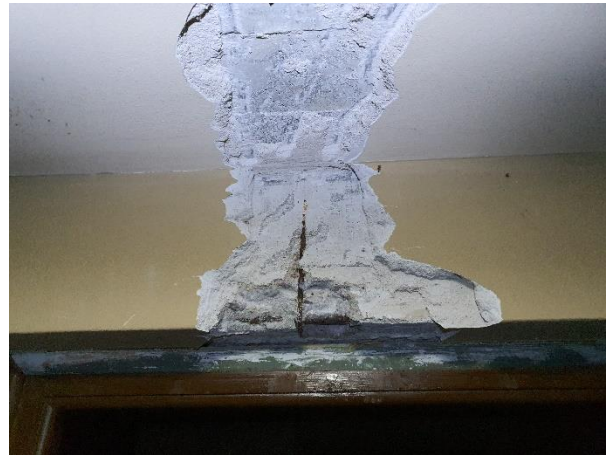
Foto 1. Vista general de la cata.
