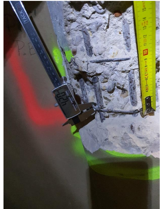
Foto 2. Medición diámetro cerco
