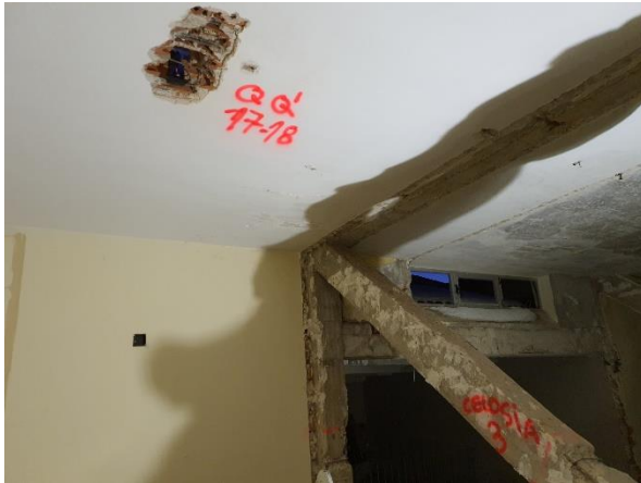
Foto 1. Vista general de la cata desde cubierta.
