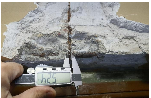
Foto 6. Medición del diámetro de los estribos.
