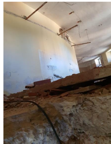
Foto 4. Vista general del pasillo en la zona curva.
