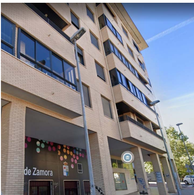
IMAGEN 3: LUMINARIAS EN ACERA OPUESTA AL CONSERVATORIO FUERA DEL TRAMO DE INTERVENCIÓN.
