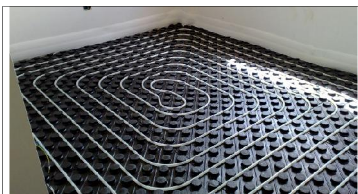
Instalación de Suelo Radiante
