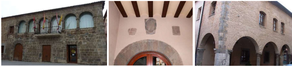
Ayuntamiento de Ágreda. Fachada principal (izquierda). Zaguán de entrada (centro). Galería porticada de la fachada lateral (derecha).
