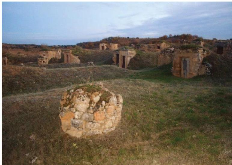
Las zarceras unen el espacio subterráneo con la superficie. Estas chimeneas de ventilación, construidas con mampostería, salen a la superficie con forma troncocónica o cilíndrica. Suelen aparecer en las bodegas de mayor longitud, donde la ventilación es más complicada, y a
