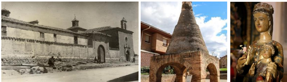
Antigua imagen del edificio del hospital (izquierda). Resto de la chimenea cónica de las cocinas (centro). Imagen de la Virgen de las Torres del siglo XIII (derecha).
