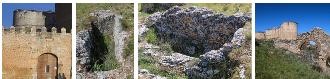
Puerta del Mercado. Tumbas de la necrópolis medieval excavadas en roca. Restos del acueducto.
