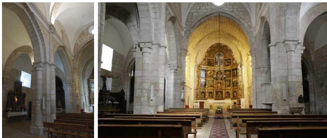
Interior de la Iglesia de Caltojar. A la izquierda detalle de los pilares cruciformes cenrales que dan apoyo a las arquerías y arcos diafragmas. A la derecha vista de la nave central, arco triunfal, presbiterio y ábside del siglo XIII.
