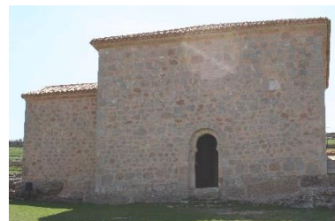
Exterior. Puerta de acceso.
