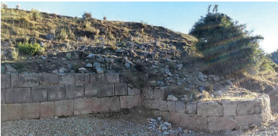
Detalle de la muralla bajo imperial romana levantada en Termes en el Siglo III d.C. Su lienzo está realizado en bloques escauadrados de sillaría y reforzado por cubos semicirculares. Tiene una anchura de 4 metros.
