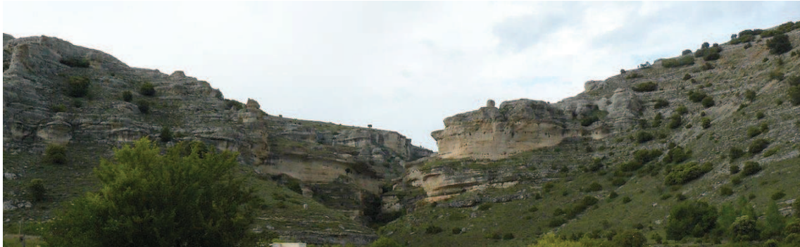
Estructuras cretácicas de calizas y dolomías de la sierra de Pela
