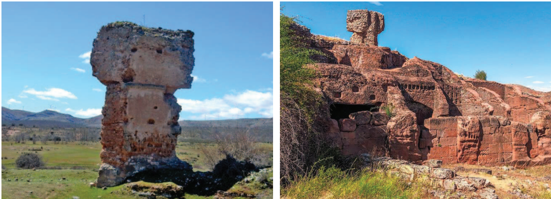
Restos del muro de una de las estancias termales. Se pueden contemplar los mechinales donde apoyaban las vigas de madera.
