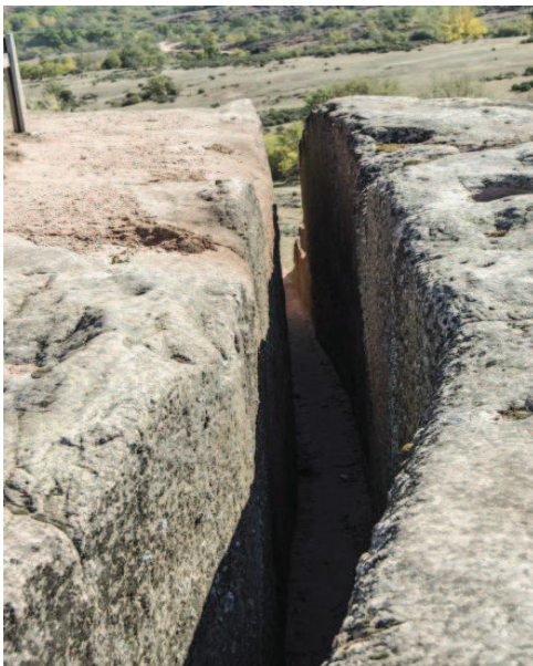
Tramo al aire libre del acueducto excavado en la roca
