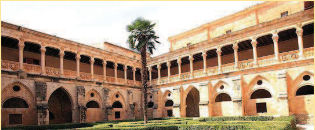
Claustro de los caballeros. El piso inferior se edificó hacia el año 1200 en estilo gótico mientras que el piso superior se añadió a partir de 1531 en estilo plateresco.
