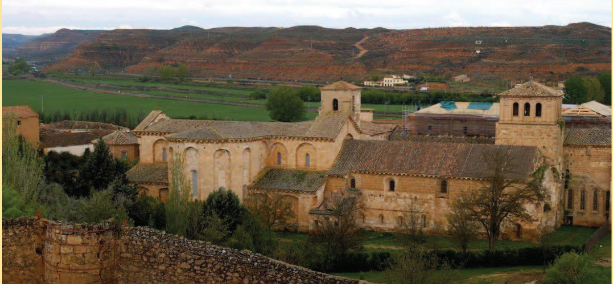
Vista del monasterio desde el Norte. Obsérvese el muro defensivo reforzado con un bastión semicircular.
