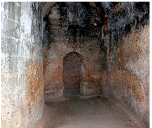
Uxama. Gran cisterna subterránea.
