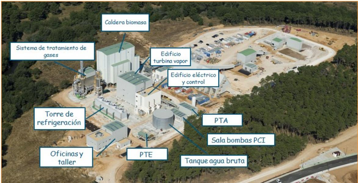
6.1. Diagrama de la planta de biomasa para la producción de energía eléctrica a partir de residuos forestales:
