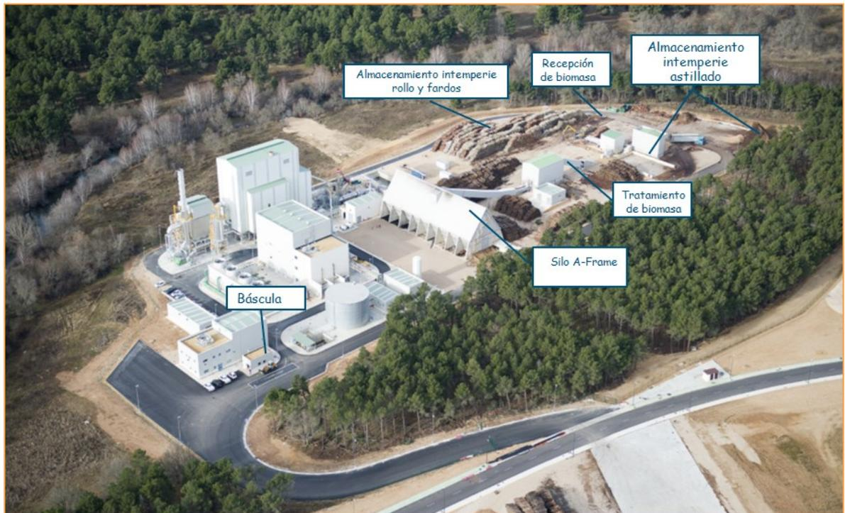
La Planta de Biomasa de Getamp - Garray es una planta de biomasa para la producción de energía eléctrica a partir de residuos forestales, aunque la etapa crítica es la producción de corriente eléctrica, el pulmón de la planta es la caldera que produce vapor de agua que servirá para mover la turbina y la generación posterior de energía eléctrica por el alternador.
