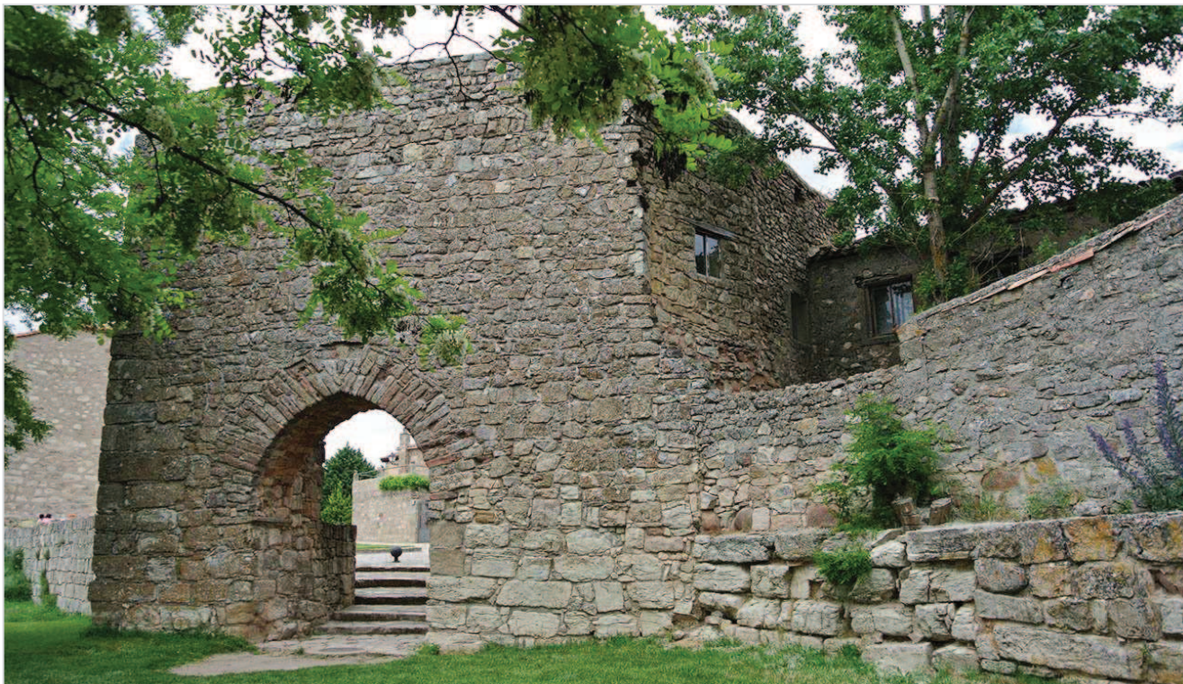
La llamada “puerta árabe” a la izquierda de la imagen da acceso a Medinaceli por el lado Oeste.
