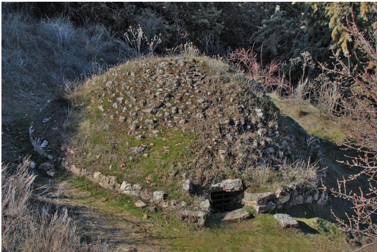
Exterior del nevero de época árabe en el que se observa su forma de montículo, debido a su cubierta en falsa cúpula
