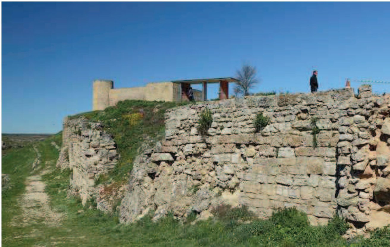
Basamento de la muralla de Medinaceli junto a la puerta de Coz
