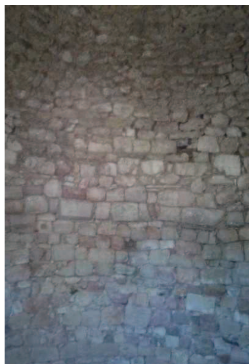
Puerta de acceso al nevero (izquierda) e interior del nevero (derecha) con estructura cilíndrica de piedras y cubierta de falsa cúpula realizada por aproximación de hiladas.
