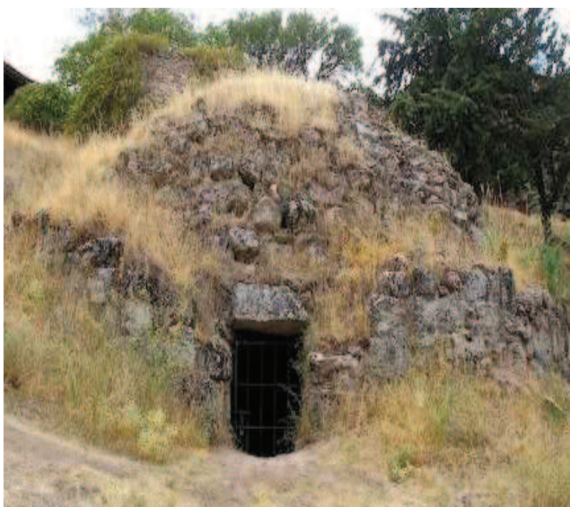
Puerta de acceso al nevero (izquierda) e interior del nevero (derecha) con estructura cilíndrica de piedras y cubierta de falsa cúpula realizada por aproximación de hiladas.
