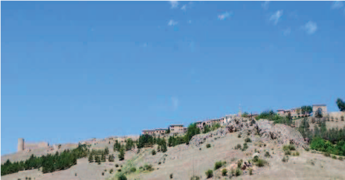
Vista de la ciudad antigua en lo alto de la meseta
