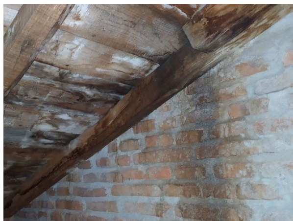
FILTRACIÓN SOBRE VESTÍBULO DE ASEOS DE PLANTA PRIMERA. ALA NOROESTE
