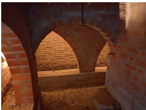
GALERÍAS DE VENTILACIÓN DE FACHADA PRINCIPAL. INTERIOR.
