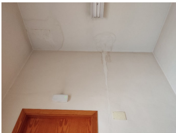
FILTRACIÓN SOBRE VESTÍBULO DE ASEOS DE PLANTA PRIMERA. ALA NOROESTE
