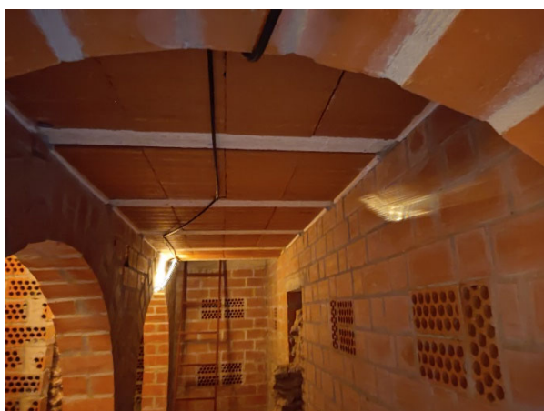
GALERÍAS DE VENTILACIÓN DE FACHADA PRINCIPAL. INTERIOR.
