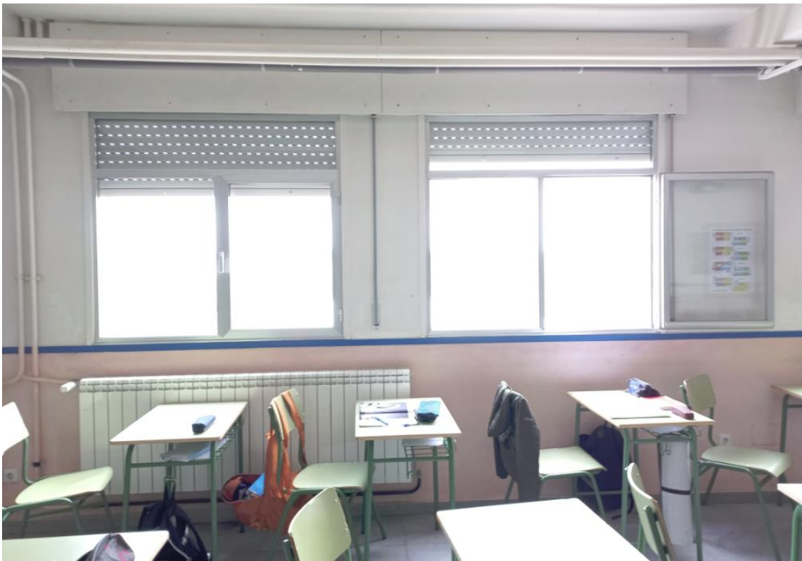
Vista interior de las aulas, donde se aprecia el tamaño de las cajoneras de persianas.
