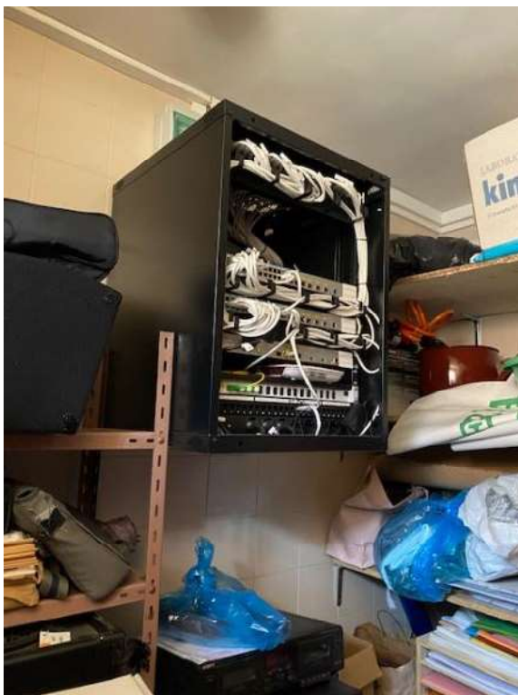
Vista parcial de almacén actual que desaparece para la ubicación del ascensor. Vista del rack de telecomunicaciones a trasladar.
