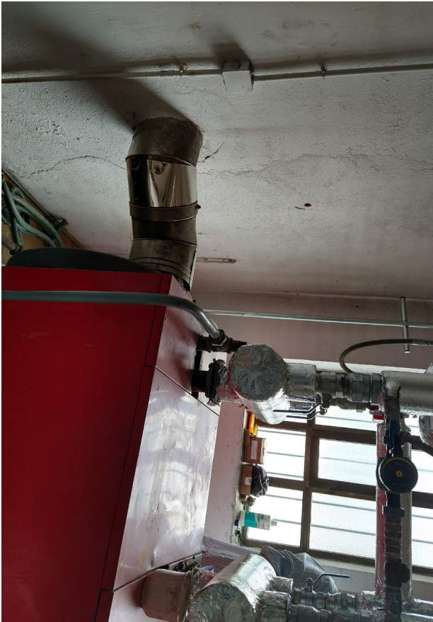
Detalle Conexión a Chimenea Actual
