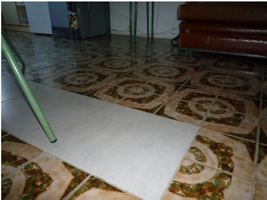
20. VISTA DEL PAVIMENTO ACTUAL DE LA SALA DE PROFESORES. SE OBSERVA EL PAVIMENTO DETERIORADO Y REPARADO EN NUMEROSAS OCASIONES CON DISTINTOS MATERIALES. QUE EN LA MAYOR PARTE DE OCASIONES SE HA COLOCADO SOBRE EL TERRAZO EXISTENTE.
