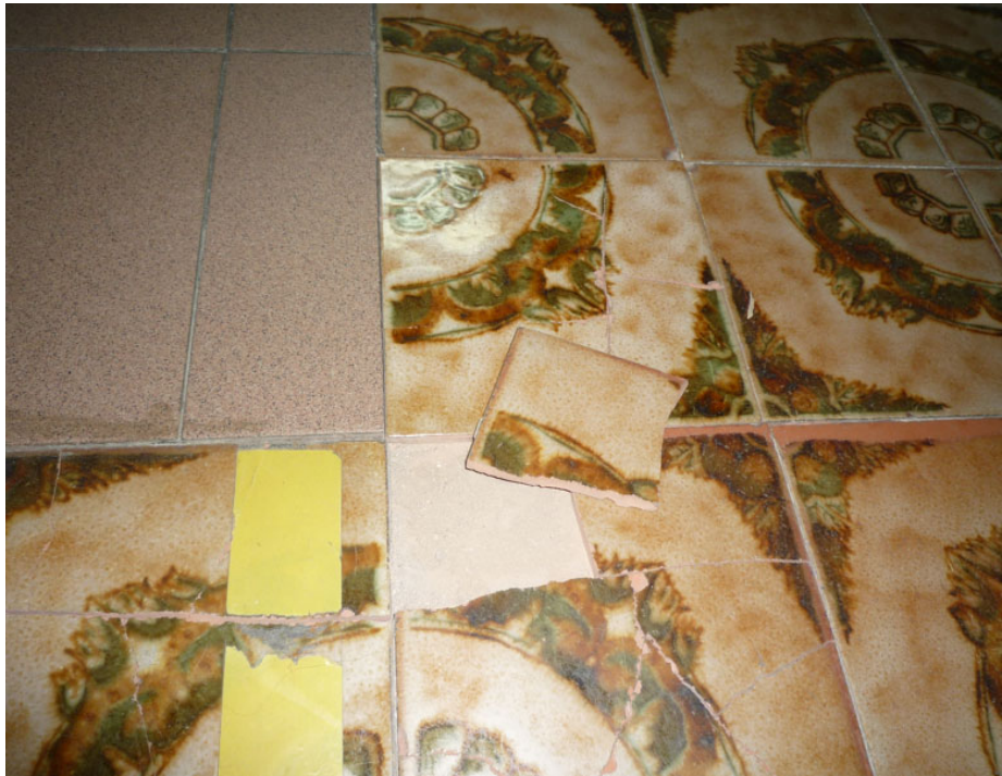
19. DETALLE DEL PAVIMENTO DETERIORADO Y REPARADO EN NUMEROSAS OCASIONES CON DISTINTOS MATERIALES.
