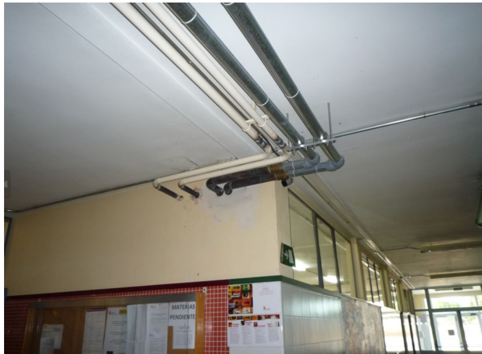
16. VISTA DE LA ZONA DE ACCESO A LA ESCALERA DESDE EL VESTÍBULO PRINCIPAL. SE OBSERVA EL CONDUCTO DE CALEFACCIÓN, JUNTO A OTROS CONDUCTOS QUE SE ENTRECRUZAN Y LOS ANCLAJES ACTUALES A TECHO, INSUFICIENTES, DÉBILES E INADECUADOS.
