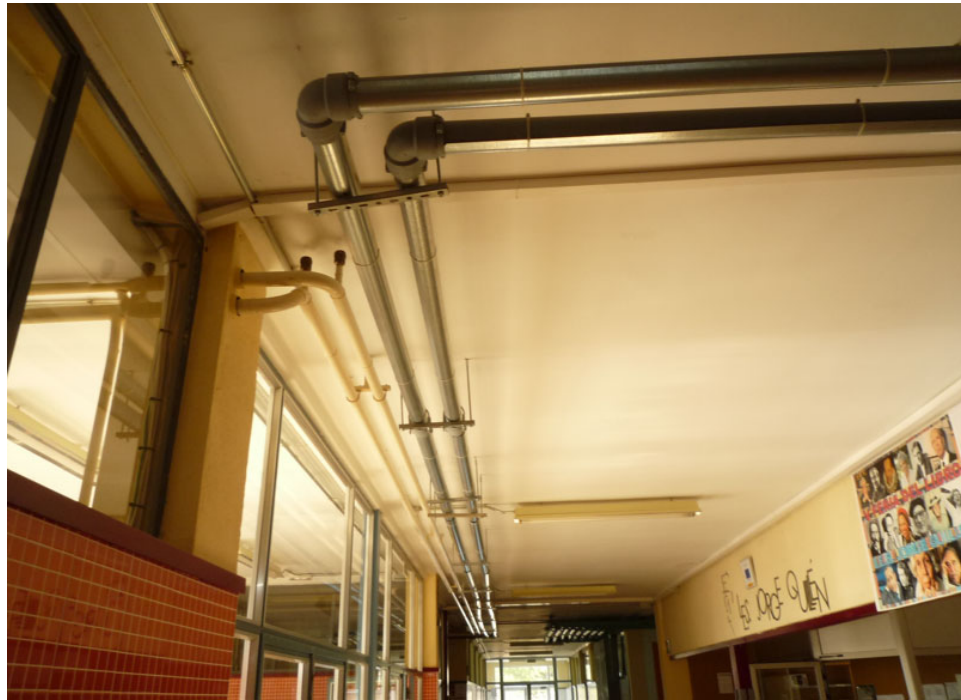
15. VISTA DEL VESTÍBULO PRINCIPAL. SE OBSERVA EL CONDUCTO DE CALEFACCIÓN, LOS ANCLAJES ACTUALES A TECHO COLOCADOS A DISTANCIAS MUY IRREGULARES.
