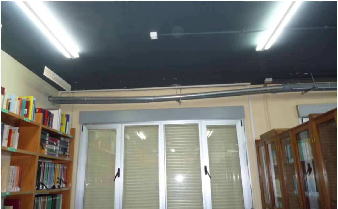
13. VISTA DE LA BIBLIOTECA. SE OBSERVA EL CONDUCTO DE CALEFACCIÓN DESPRENDIDO DEL TECHO POR CEDIMIENTO DEL ANCLAJE.
