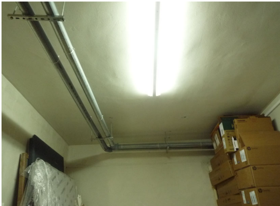
14. VISTA DEL ALMACÉN JUNTO A LA BIBLIOTECA. SE OBSERVA EL CONDUCTO DE CALEFACCIÓN, LOS ANCLAJES ACTUALES A TECHO Y LAS VAINAS DE APOYO BAJO LOS MISMOS.
