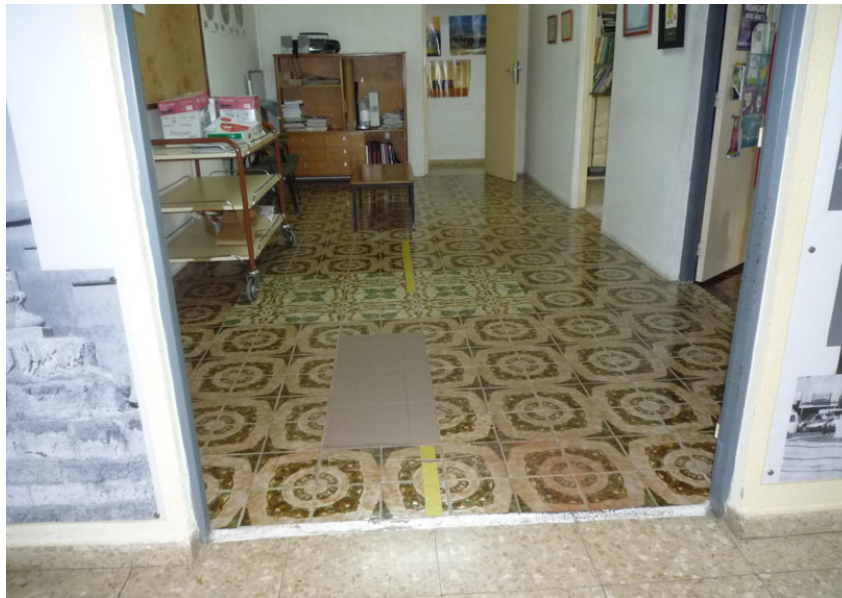
18. VISTA DEL VESTÍBULO DE ADMINISTRACIÓN, DESDE DONDE SE ACCEDE A LA SALA DE PROFESORES. SE OBSERVA EL PAVIMENTO DETERIORADO Y REPARADO EN NUMEROSAS OCASIONES CON DISTINTOS MATERIALES QUE EN LA MAYOR PARTE DE OCASIONES SE HA COLOCADO SOBRE EL TERRAZO EXISTENTE.
