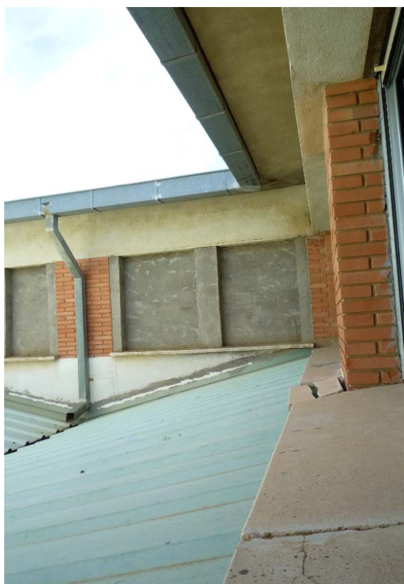
12. CUBIERTA Q2 Y SU ENCUENTRO CON EL EDIFICIO 1. SE OBSERVA EL DETERIORO DE ALFÉIZARES Y EL CIERRE IMPROVISADO DE VENTANALES DEL SALÓN DE ACTOS.
