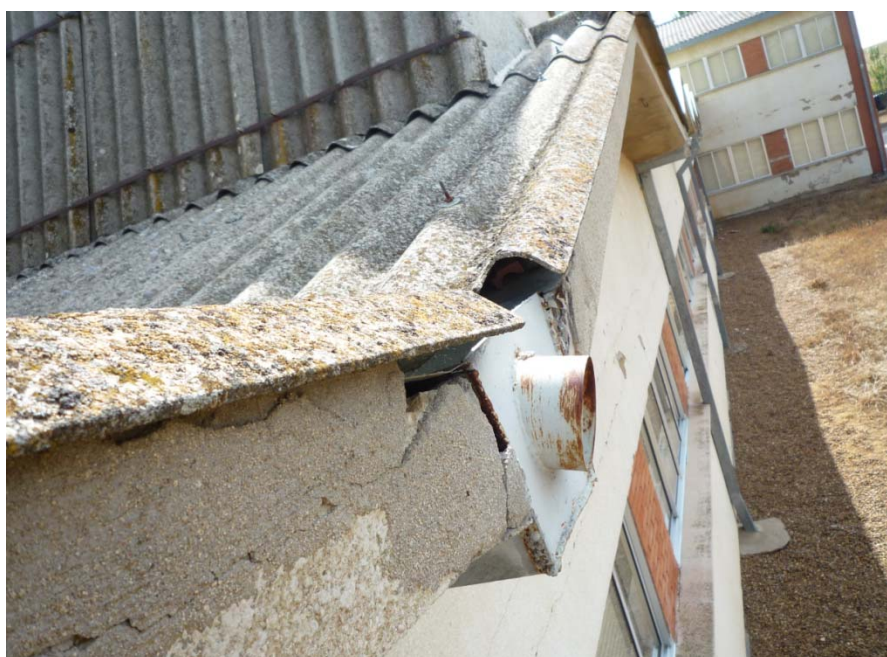
19. VISTA DEL EXTREMO DEL PESEBRÓN DE CHAPA, CON REBOSADERO ABIERTO AL PATIO. SE OBSERVA EL ENCUENTRO ENTRE ÉSTE Y EL ALERO, MUY DEGRADADO.
