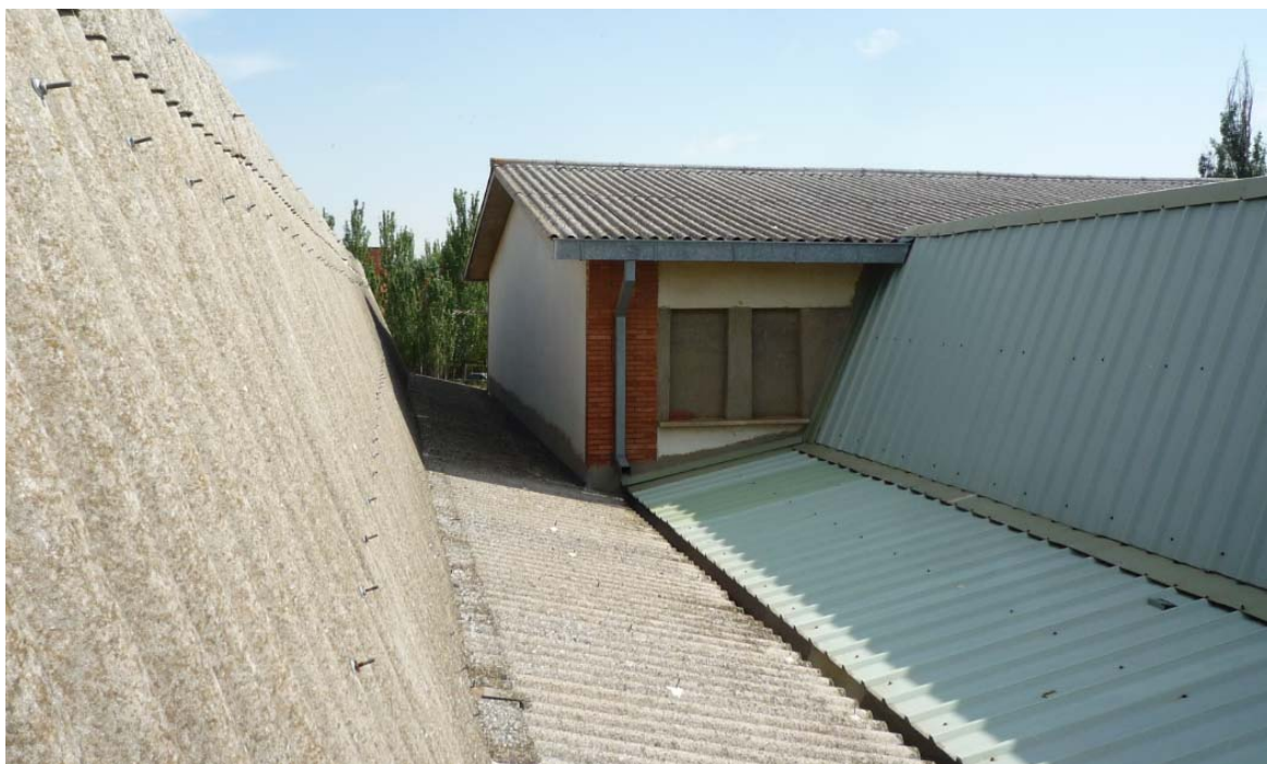
16. ENCUENTRO ENTRE LAS CUBIERTAS DE LOS EDIFICIOS 1, 2 Y 3. SE OBSERVA LA INTERRUPCIÓN DEL CANALÓN DE LA CUBIERTA DEL EDIFICIO 1 AL LLEGAR A LA MONTERA DEL EDIFICIO 2.
