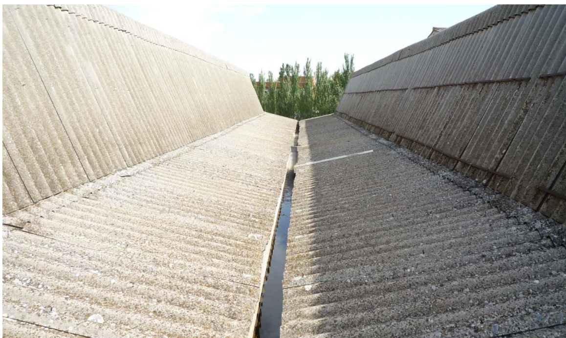
17. LA CUBIERTA Q3 DE FIBROCEMENTO. EN EL CENTRO PESEBRÓN DE RECOGIDA DE AGUAS CON VERTIDO A LAS FACHADAS NORTE Y SUR. SE OBSERVA LA PRESENCIA DE AGUA ESTANCADA Y A LA DERECHA, EL ATADO DE FALDONES DE LA MONTERA CON PLETINAS DE ACERO.
