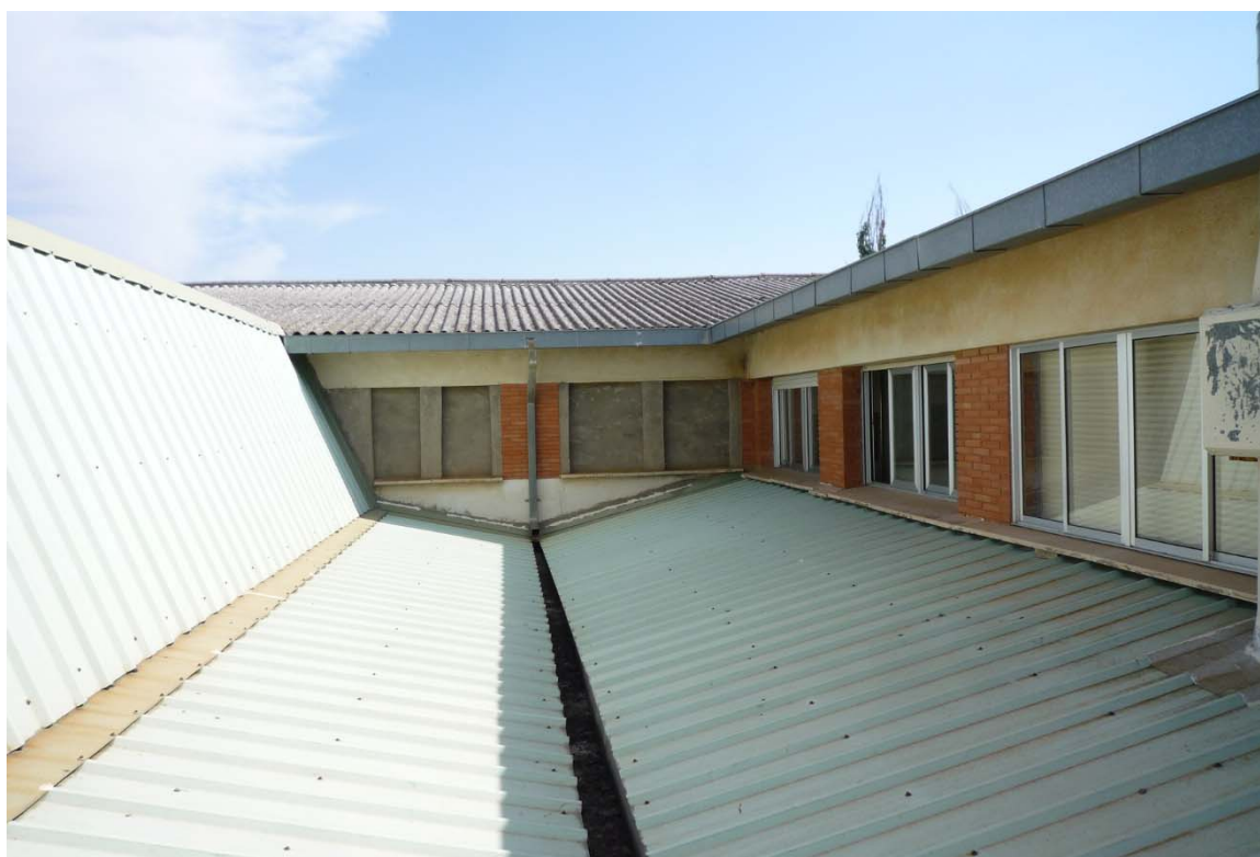
14. LA CUBIERTA Q2 EN PRIMER TÉRMINO, DE CHAPA. LA CUBIERTA Q1 AL FONDO, DE FIBROCEMENTO.
