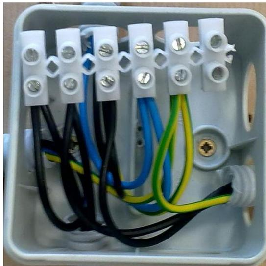
Caja de derivación con empalmes correctamente realizados. Fuente: [blogspot](#)
