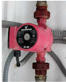
Bomba de presión Fuente: Wikimedia commons
