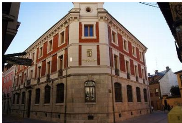
Imagen 44. Sede del Procurador del Común de Castilla y León.
