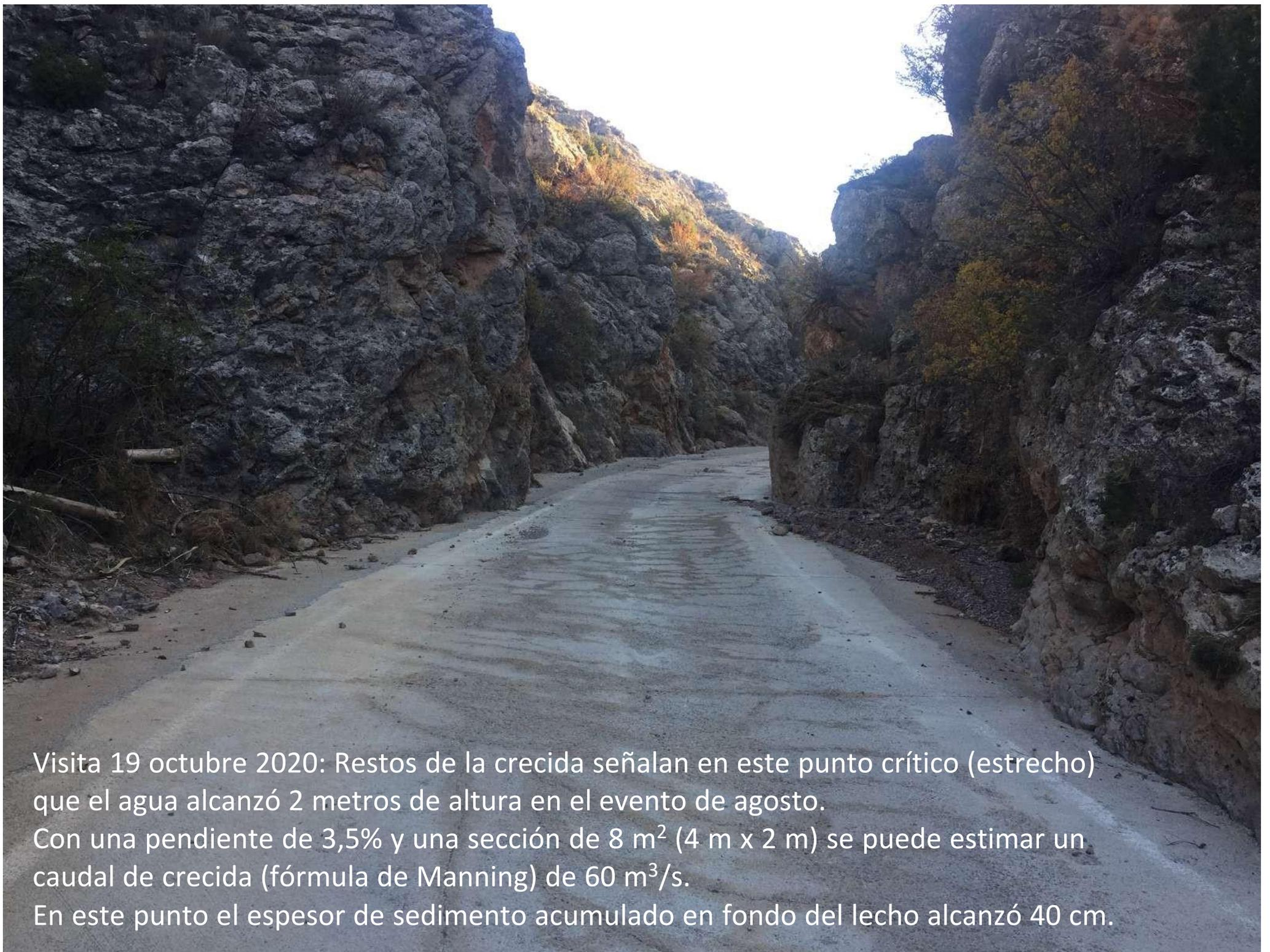
Visita 19 octubre 2020: Restos de la crecida señalan en este punto crítico (estrecho) que el agua alcanzó 2 metros de altura en el evento de agosto. Con una pendiente de 3,5% y una sección de  $8 \text{ m}^2$  (4 m x 2 m) se puede estimar un caudal de crecida (fórmula de Manning) de  $60 \text{ m}^3/\text{s}$ . En este punto el espesor de sedimento acumulado en fondo del lecho alcanzó 40 cm.
