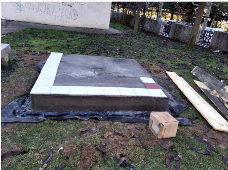
Imagen 8. Colocación de baldosas. Fuente: Elaboración propia
