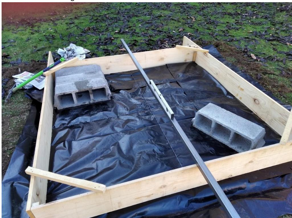
Imagen 4. Colocación de capa plástica. Fuente: Elaboración propia
