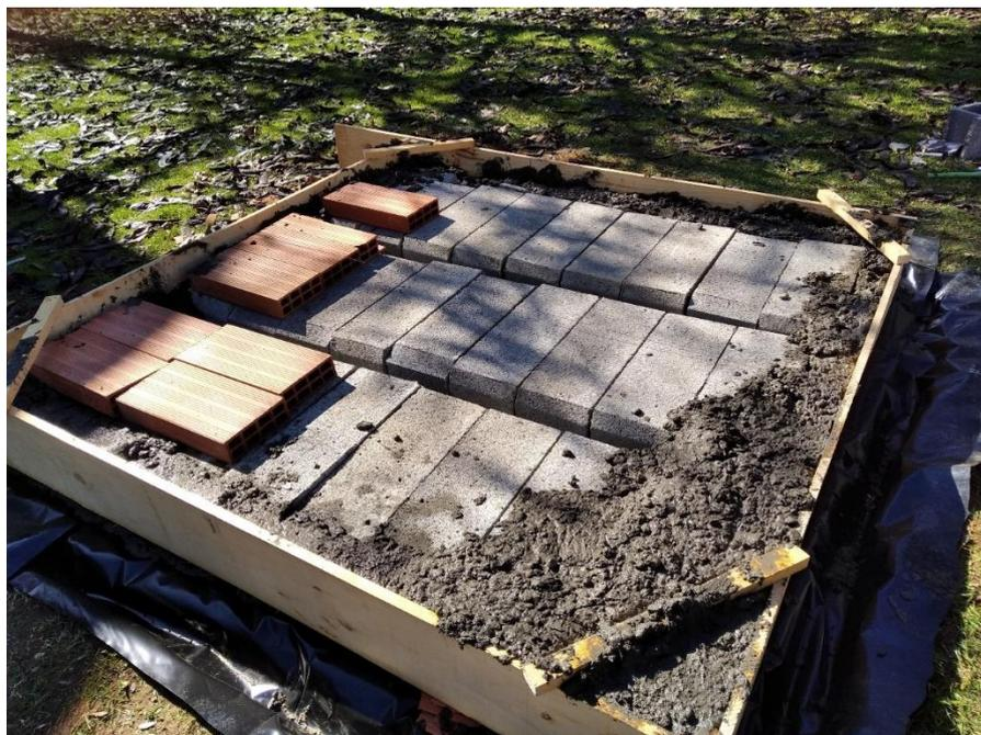
Imagen 6. Hormigón, bovedillas y encofrado. Fuente: Elaboración propia
