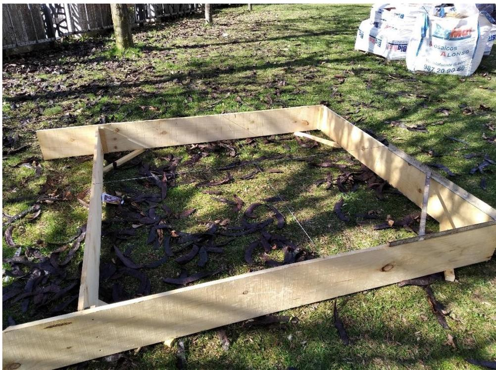
Imagen 2. Encofrado. Fuente: Elaboración propia
