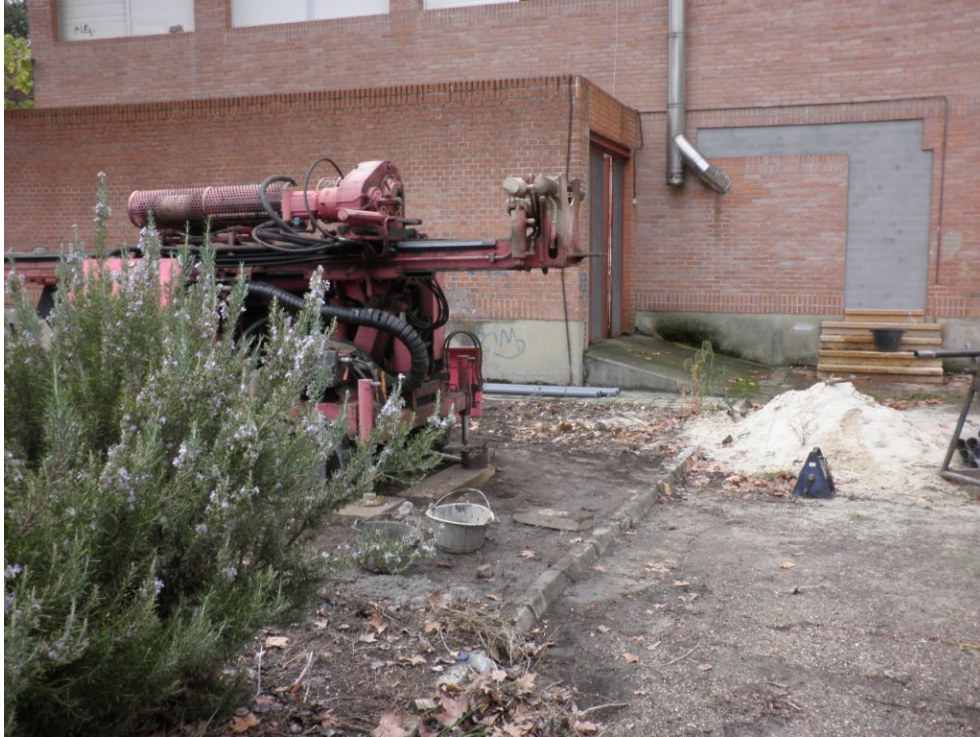
SONDEO MECÁNICO S-2 BIS.
