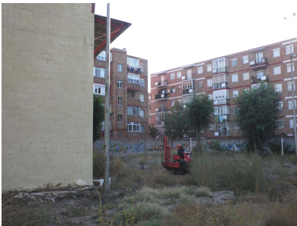
PENETRACIÓN DINÁMICA. VISTA "D"
