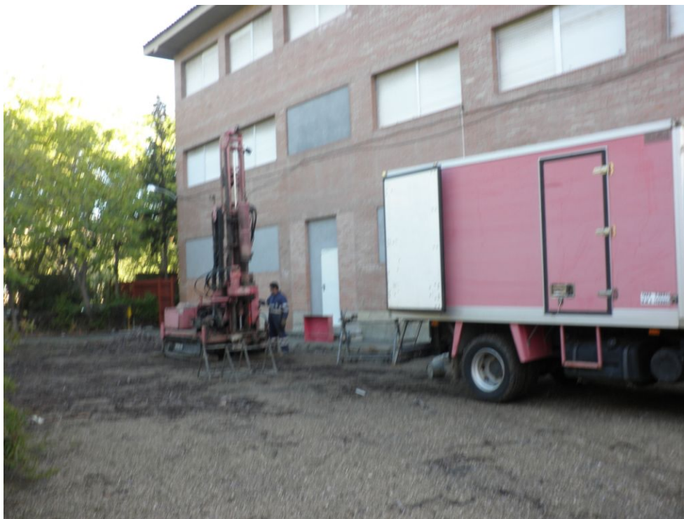
SONDEO MECÁNICO S-3. VISTA "A"
