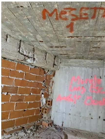
Imagen 02.- Vista general cara inferior de losa y viga de escalera entorno al pilar S'1'.
