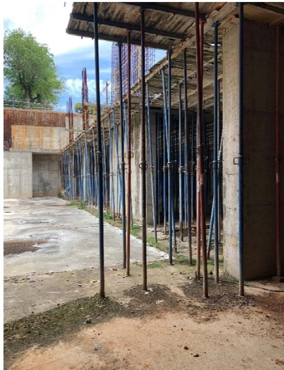
OBRA EJEC. FORJADO ENTABLADO Y APUNTALADO SOT.-2
