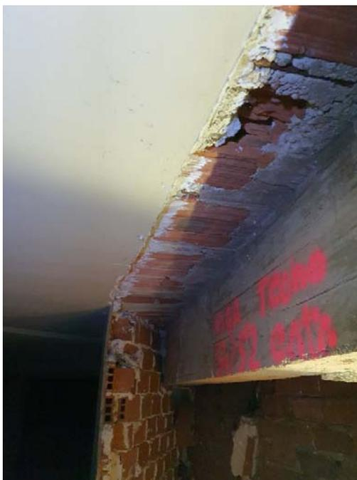
Imagen 03.- Vista general cara inferior de forjado unidireccional 1ª planta, viga S4-S'2.
