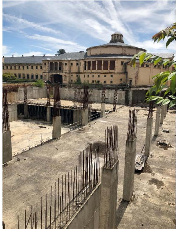
OBRA EJEC. SÓTANOS, PILARES SOTANO -1 Y ESPERAS
