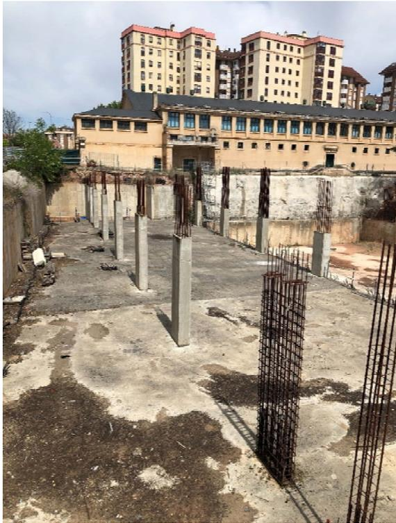
OBRA EJEC.FORJADO SÓTANO -1, PILARES CON ESPERAS
