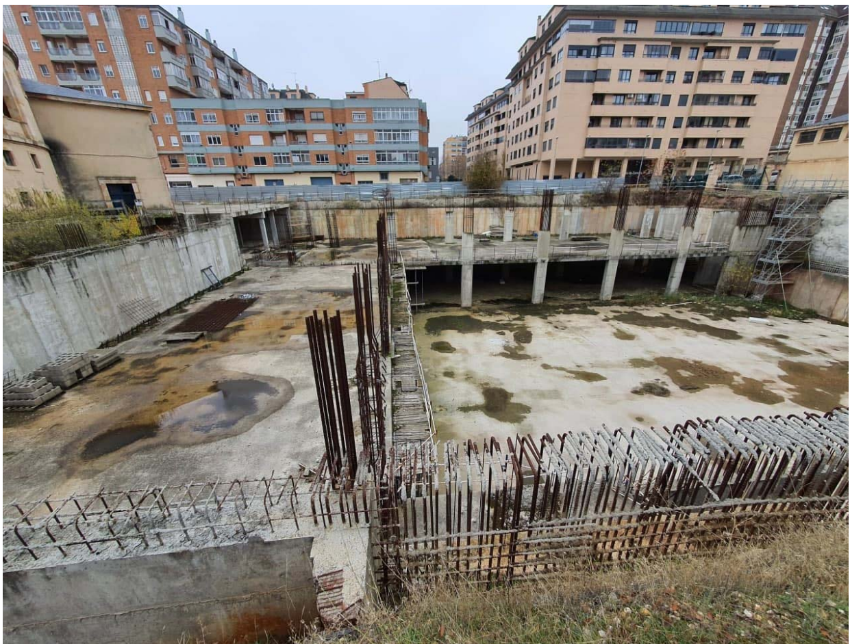
Vista general de elementos estructurales ejecutados. Foto 2 de 3.
