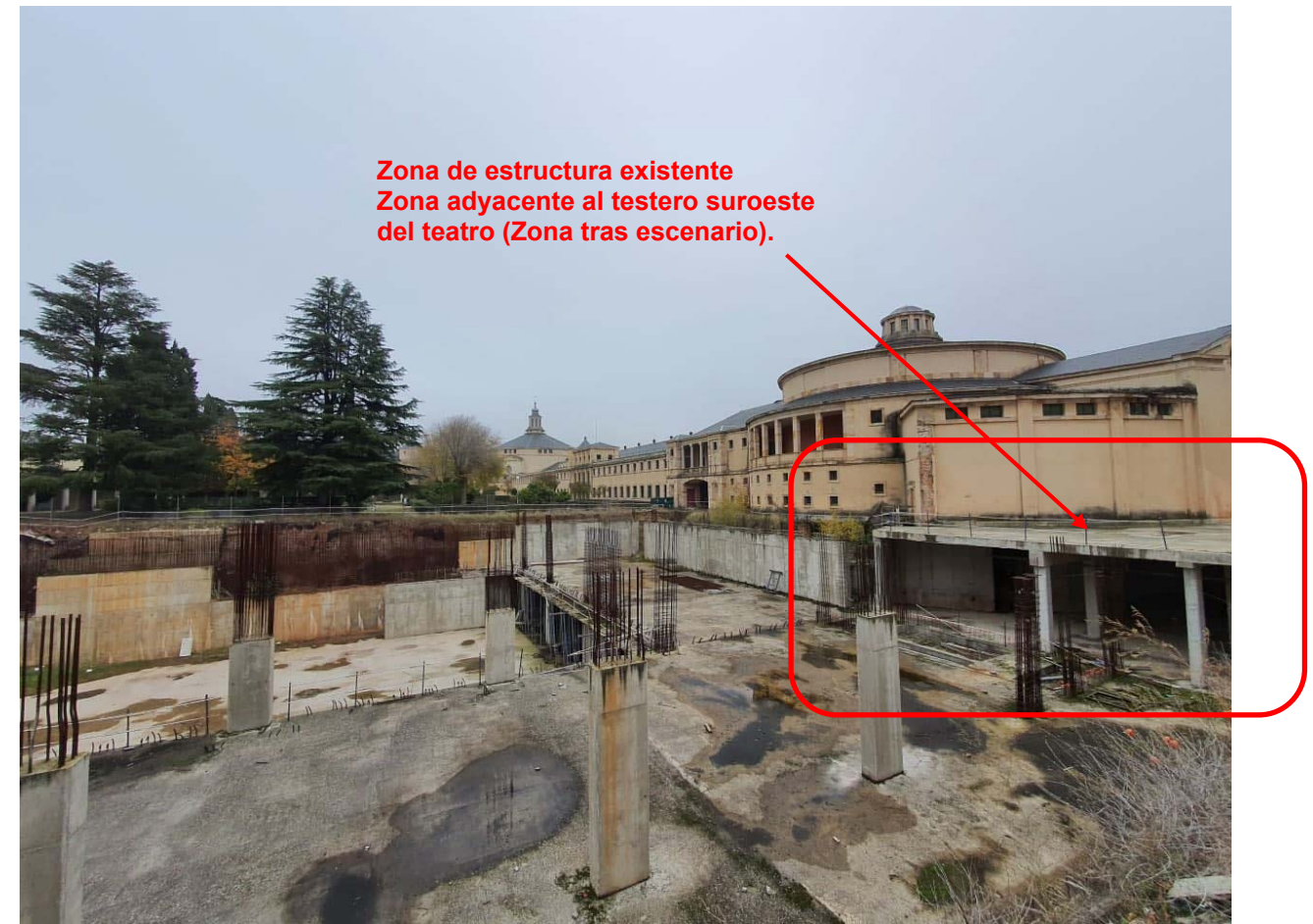
Vista general de elementos estructurales ejecutados. Foto 3 de 3.
