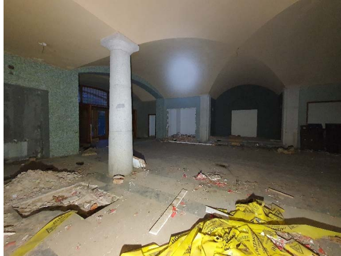
Vista general del vestíbulo. Pilares de granito y bóvedas de arista en techo de planta baja.
