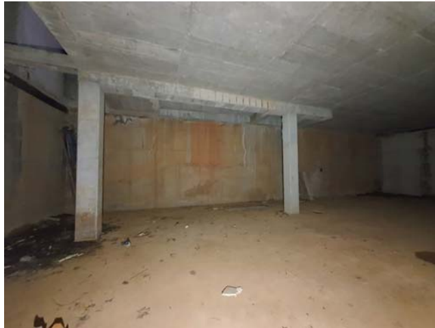
Zona adyacente al teatro. Fotografía de sótano -2. Fotografía 3 de 3.
