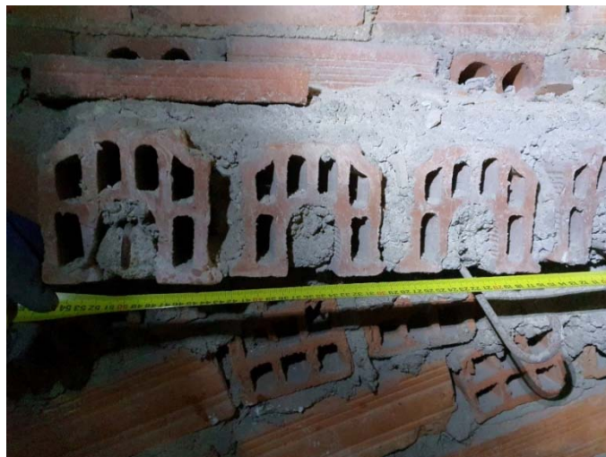
Forjado unidireccional con viguetas del tipo "violín".
