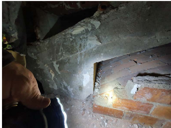
Vista lateral de losa inclinada de la platea alta, y vista superior de la bóveda de cañón. Detalle del encuentro entre viga de canto, bóveda y losa inclinada.
