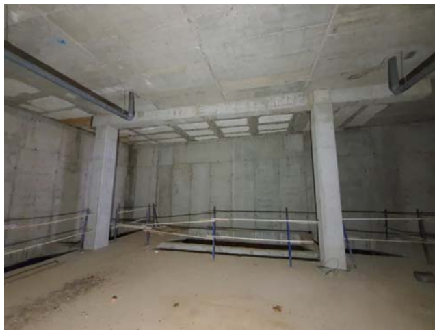
Zona adyacente al teatro. Fotografía de sótano -1. Fotografía 1 de 1.
