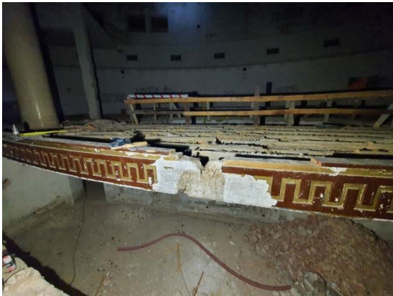
Zona escenario. Forjado de losa de hormigón armado en voladizo.
