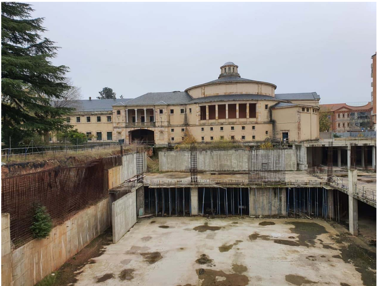
Vista general de elementos estructurales ejecutados. Foto 1 de 3.
