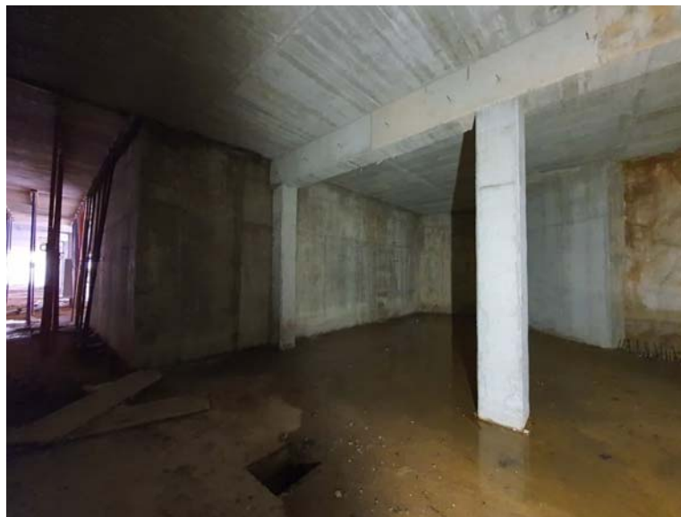
Zona adyacente al teatro. Fotografía de sótano -2. Fotografía 2 de 3.
