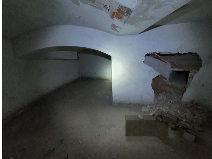
Zona escenario. Bóvedas de cañón.
