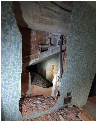
Vista lateral de losa inclinada de la platea alta, y vista superior de la bóveda de cañón. Detalle del encuentro entre viga de canto, bóveda y losa inclinada.
