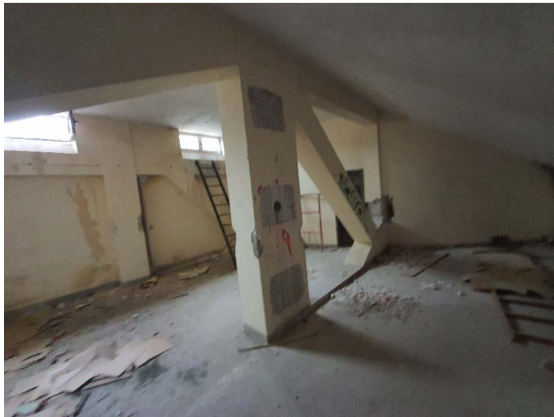
Nivel de planta bajo cubierta, con fracción de celosía de hormigón de grandes dimensiones.
