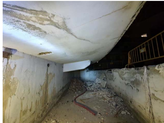
Zona escenario. Forjado de losa de hormigón armado en voladizo.
