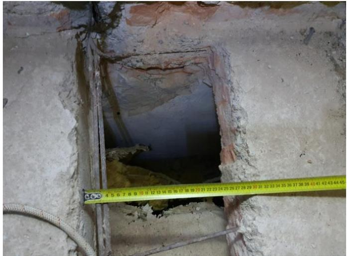
FOTO 107-108 – Vista general del forjado en la zona curva y detalle de la cata realizada para determinar los refuerzos de negativos de la vigueta.
