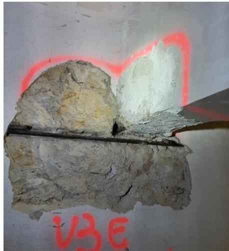
FOTO 46 – Encuentro entre muro de mampostería y viga del forjado del escenario. Viga V3E
