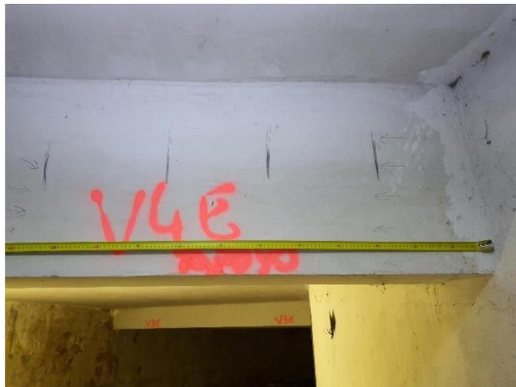
FOTO 55 – Pachometría realizada junto al apoyo de la viga en el muro de mampostería
