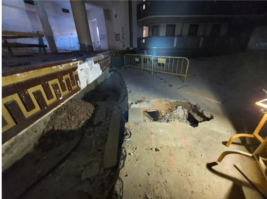
FOTO 17 – Vista general de la cata 8 INC, en la solera inclinada de la platea.
