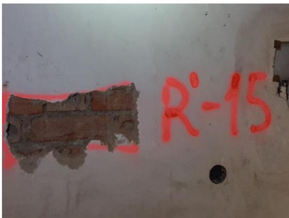
Foto 3. Roza en muro donde se observa fábrica de ladrillo resistente.
