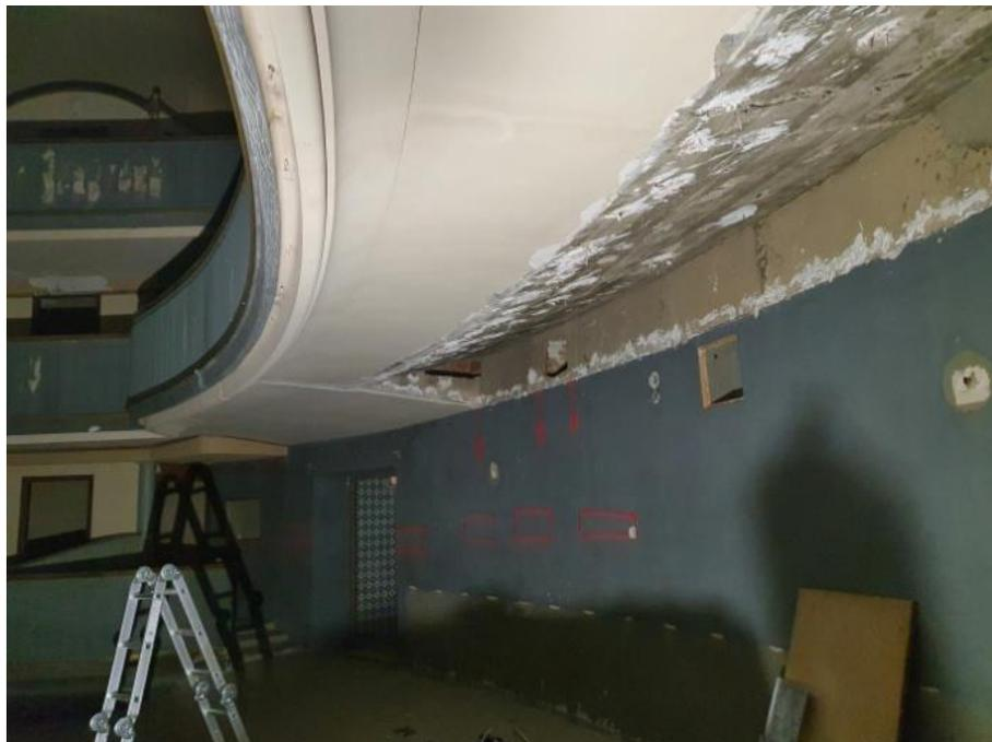
FOTO 97 – Vista general de la cara inferior de la losa en la zona de la platea alta, donde se observa que el final del voladizo es una losa horizontal que está conectada con la inclinada.
