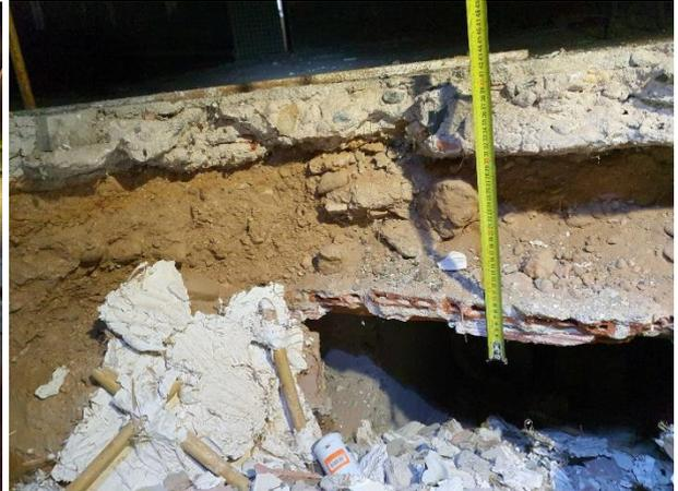
Foto 2. Medida del espesor de la solera.
