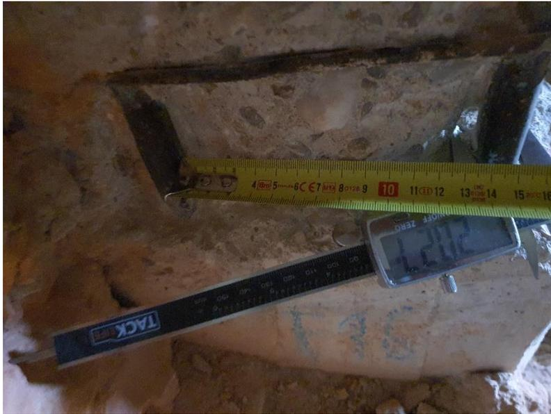
Foto 1. Medición del diámetro de la armadura del pilar y la distancia entre las mismas. Se estima que hay tres armaduras en la cara X del pilar
