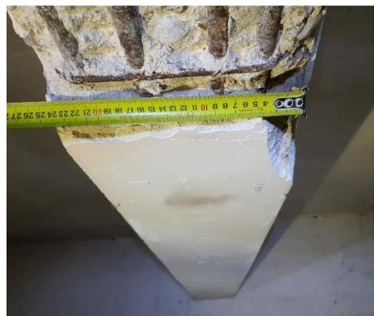
FOTO 56 y 57 – Caracterización del armado de positivos de la viga.
