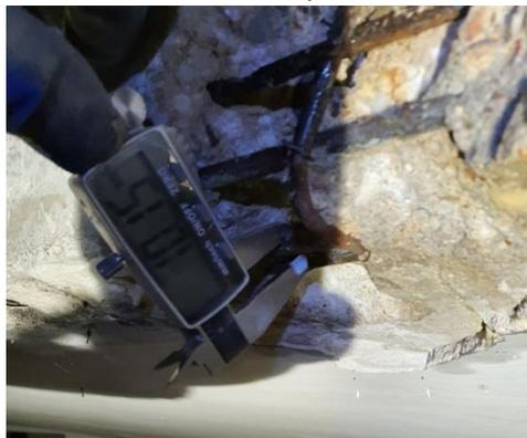
Foto 5. Medida del diámetro de la armadura inferior
