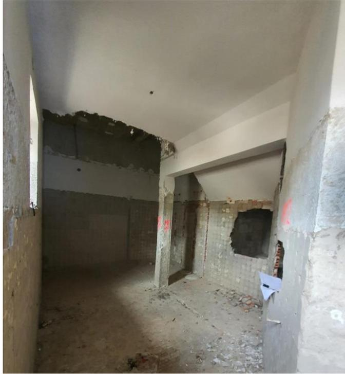
FOTO 88 – Vista general de la zona de las escaleras, donde se observa un hueco en muro.
