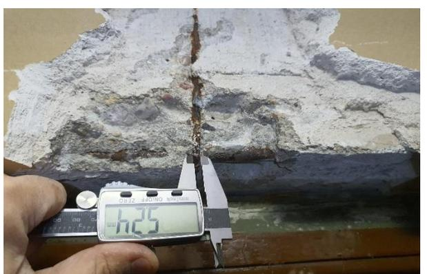
Foto 6. Medición del diámetro de los estribos.
