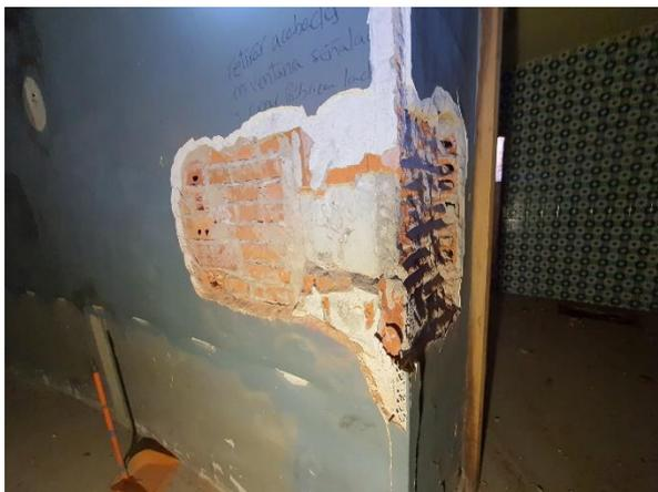
Foto 3. Rozas en muro donde se observa un pilar de hormigón de sección cuadrada-
