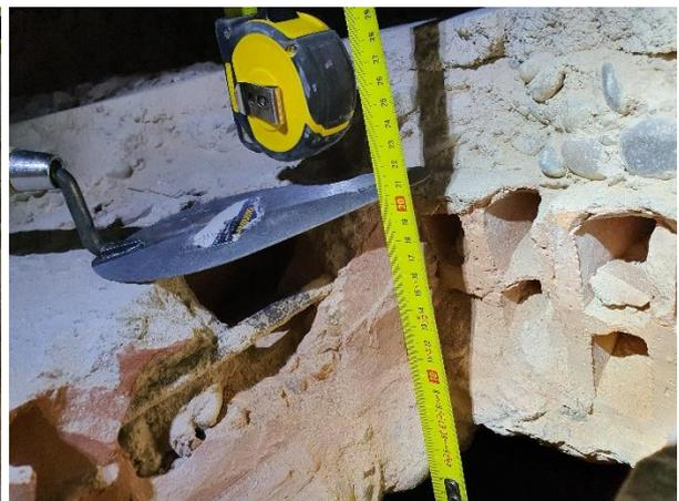
Foto 4. Medición del canto del forjado
