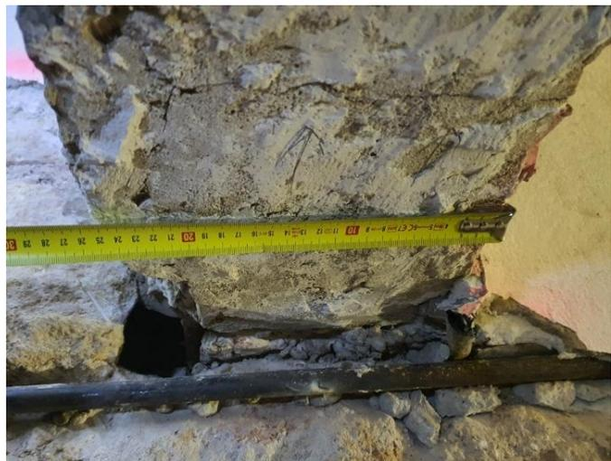
FOTOS 47 y 48 – Caracterización de la viga. Medición del cuelgue y ancho de la viga.
