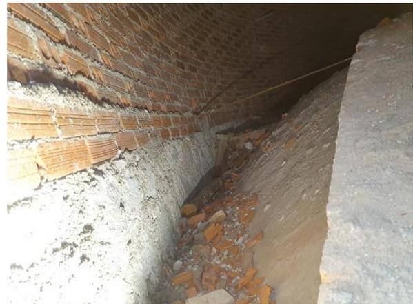
Foto 4: Se observa el muro de mampostería de la 1ª Planta y sobre el que se apoya una fábrica de ladrillo hueco.
