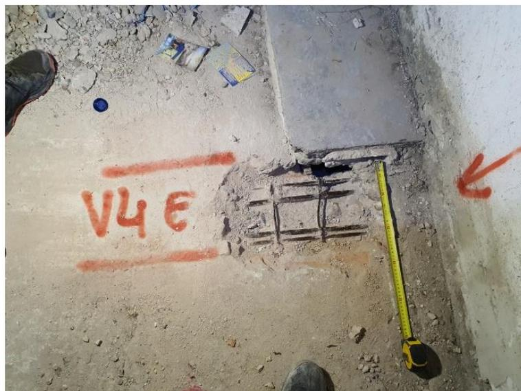
FOTO 59 – Cata 10 de Intemac. Cata de negativos junto al apoyo de la viga en el muro de mampostería
