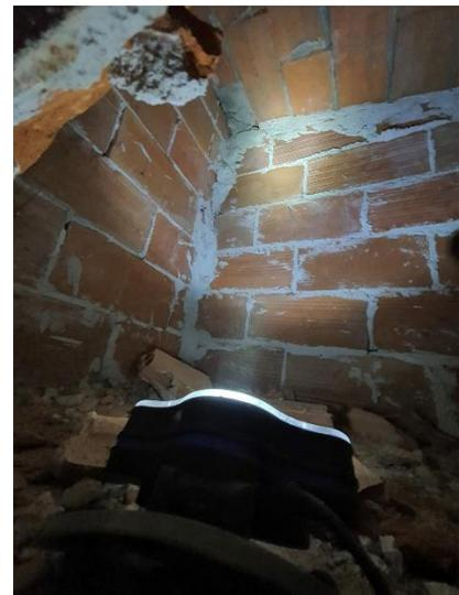
Foto 4. Interior de la cambra donde se observan los taquiques conejeros que sirven de apoyo al forjado de la cubierta.
