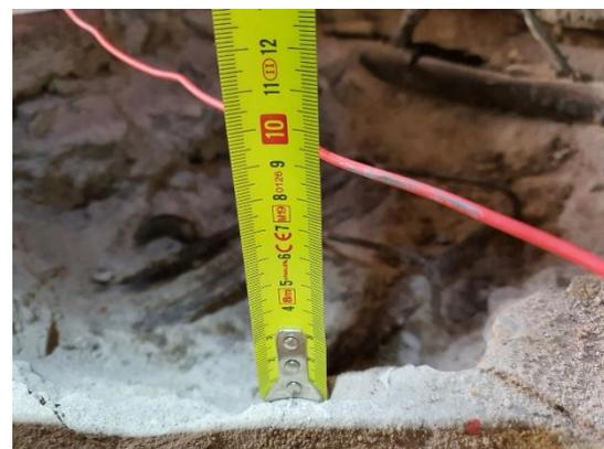
Foto 5-6: Medida del espesor de recubrimiento de las armaduras y de las cargas muertas.
