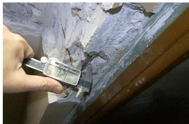
Foto 5. Medición de la armadura inferior.
