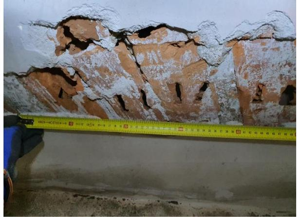
Foto 2. Medida del intereje y ancho de vigueta.
