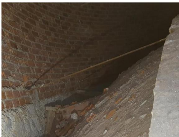
Foto 5: Detalle de tirante metálico .
