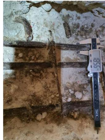
Foto 3-4: Medida del diámetro del armado de negativos de la viga.
