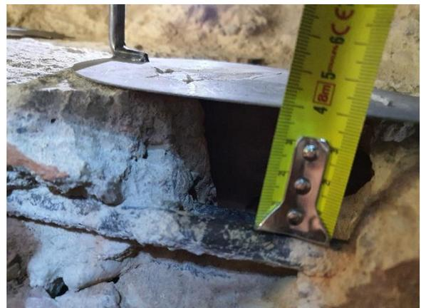
Foto 6. Recubrimiento armadura negativos
