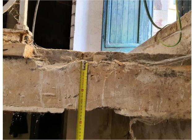
FOTOS 63 y 64 – Cata 6 realizada por INCOSUMA, en la cara inferior del forjado.
