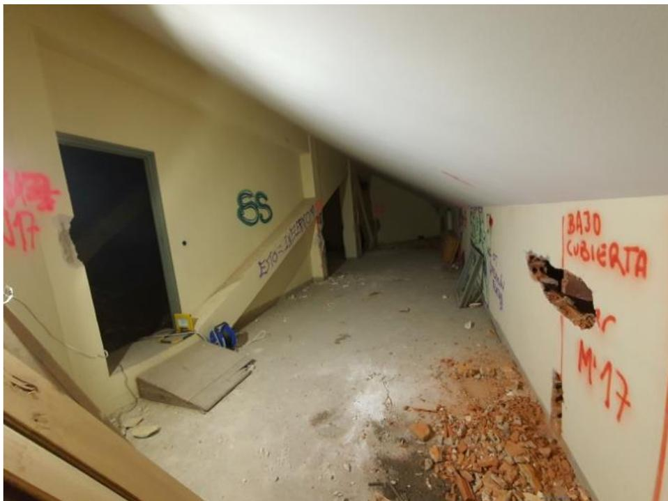
FOTO 117 – Vista general donde se observa la apertura en el muro para caracterizar el apoyo del forjado inclinado de la cubierta.
