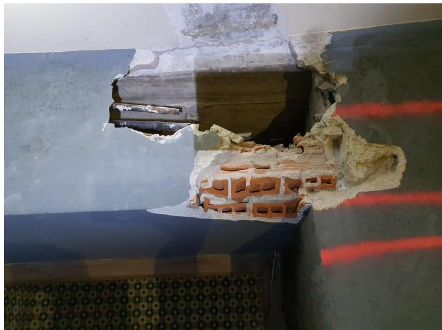
Foto 1-2: Comprobación de la viga de hormigón.
