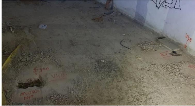
FOTO 58 – Vista general de la cara superior del escenario. Se observan dos catas de negativos realizadas sobre la viga V4E, junto al apoyo en muro. Catas 9 y 10 de Intemac
