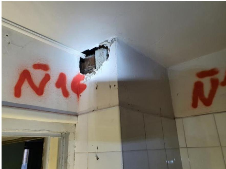
FOTO 111 – Detalle de cata realizada para detectar la existencia del pilar de hormigón.
