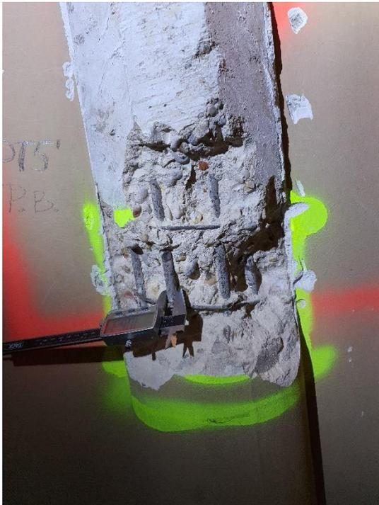
Foto 1. Medición diámetro armadura
