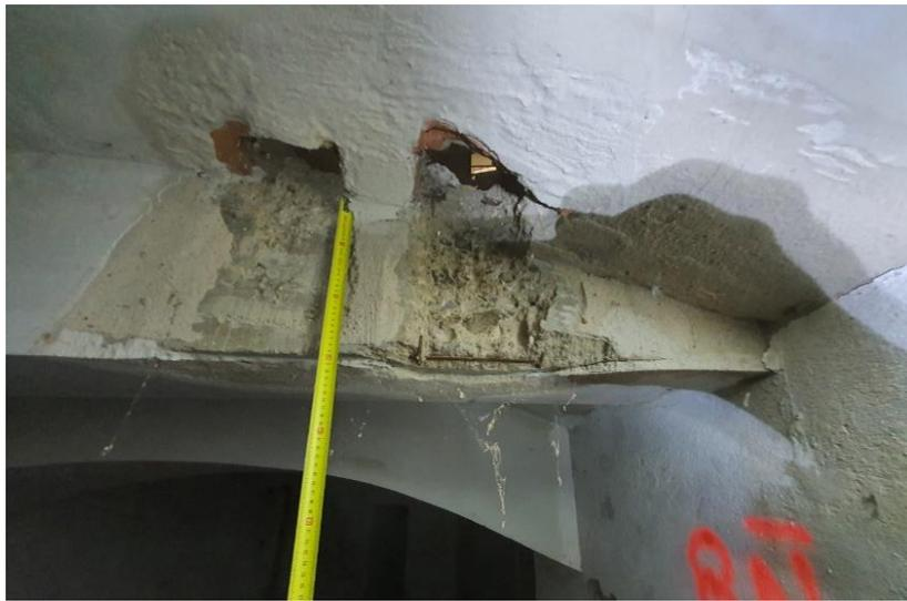
FOTO 65 – Cata 7 realizada por INCOSUMA en la viga y la cara inferior del forjado del escenario.
