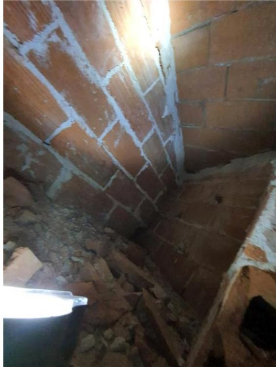
FOTO 120 – Detalle del interior de la cata, donde se observa la disposición de tabiques conejeros, sobre los que se apoya el forjado de cubierta.
