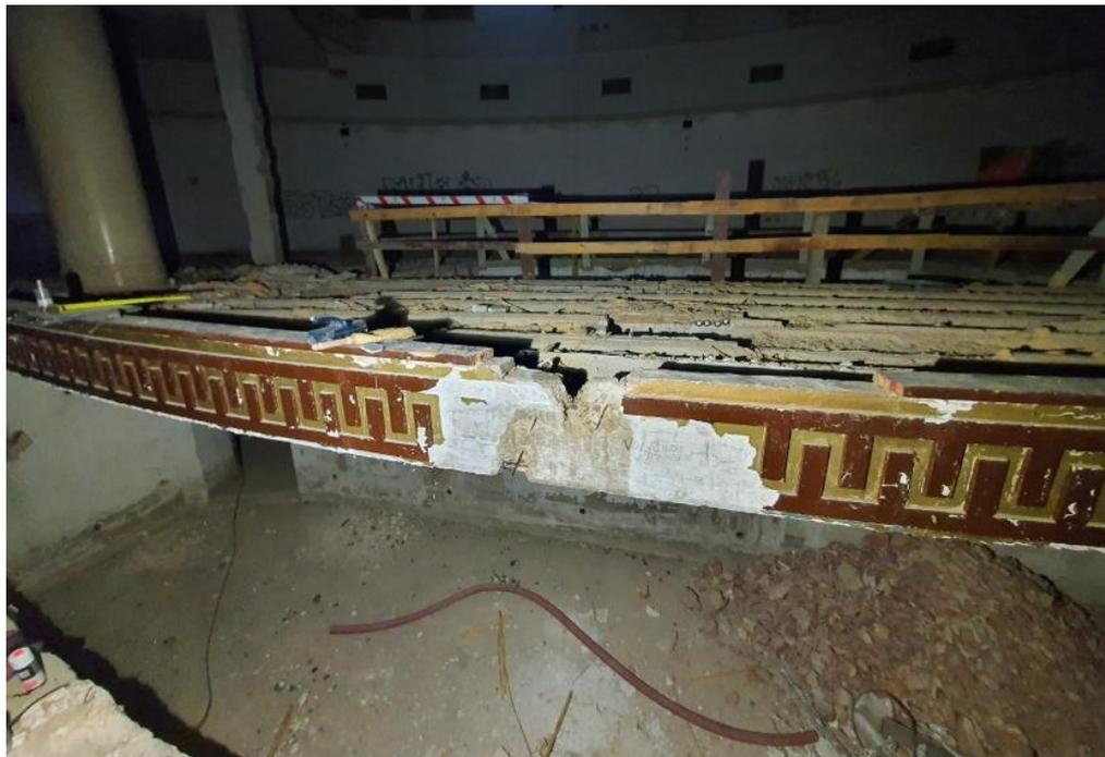
FOTO 76 – Vista general de la cata realizada en el zuncho de borde de la losa del escenario.
