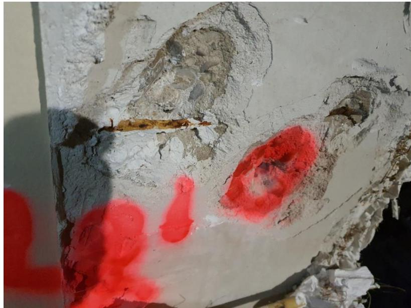
Foto 1-2-3: Vista general y detalle de la cata realizada en el zuncho de borde de la platea alta, para comprobar la existencia del armado inferior. Se observa la elevada oxidación de la armadura.
