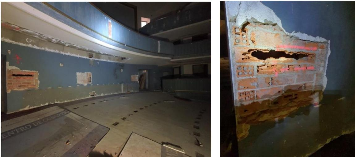
FOTO 82-83 – Vista general y detalle de cata para localizar huecos en el muro curvo.
