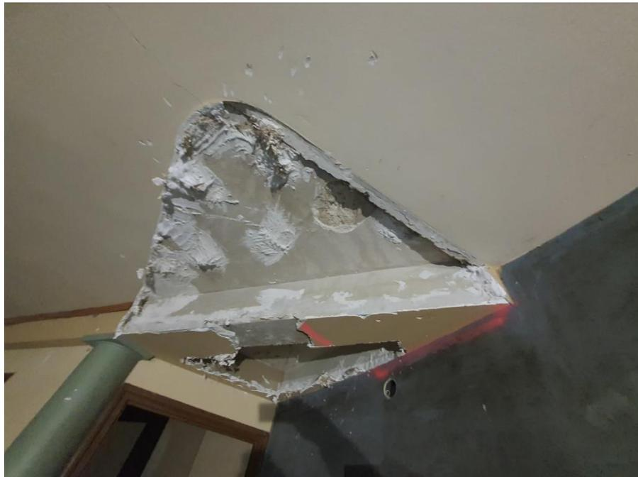
Foto 1-2-3: Comprobación de la viga de hormigón.
