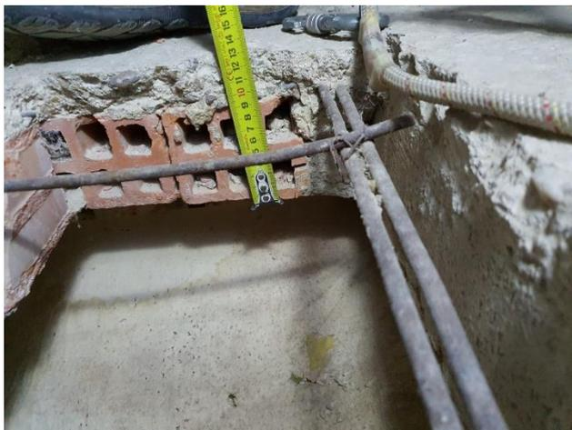
Foto 3. Medida del espesor del forjado
