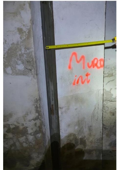
FOTOS 26 y 27- Caracterización del muro del anillo exterior bajo el escenario. En la foto 26 se ha retirado el recubrimiento para determinar la materialidad del muro y en la foto 27 se caracteriza el ancho del muro.
