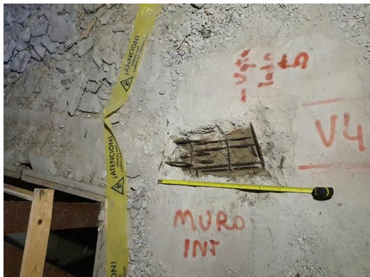
FOTO 60 – Cata 9 de Intemac. Cata de negativos junto al apoyo de la viga en el muro de mampostería
