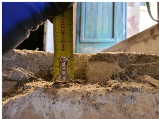
Foto 5. Medida del espesor de las carga muertas.
