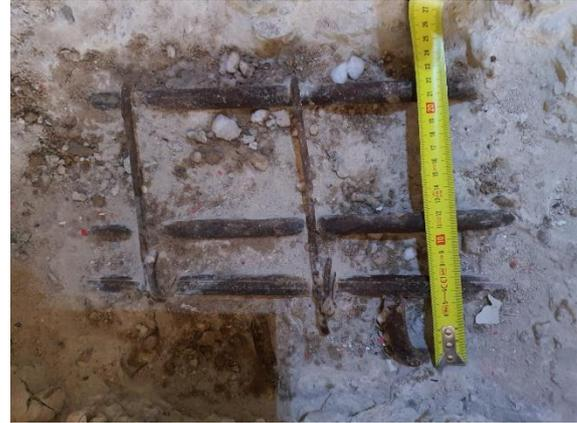
Foto 2. Medida aproximada del ancho de la viga.
