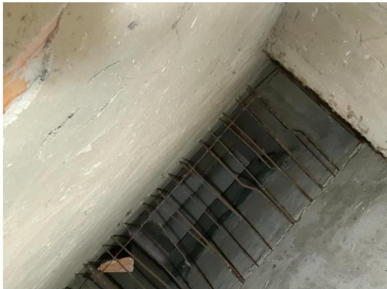
FOTO 86-87 – Vista del interior del hueco, una vez realizada la cata en el muro de partición.
