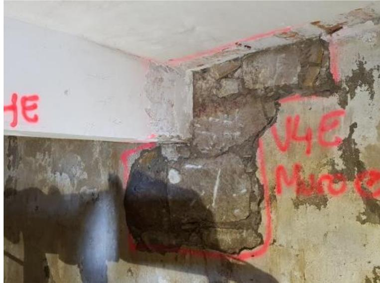
FOTO 54 - Encuentro entre muro de mampostería y viga del forjado del escenario. Viga V4E
