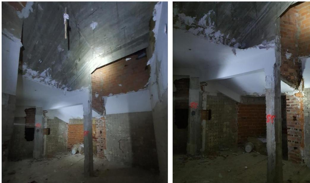
FOTO 91-92 – Vista general de la zona de las escaleras, donde se observa la estructura de hormigón sobre la que apoya la losa.
