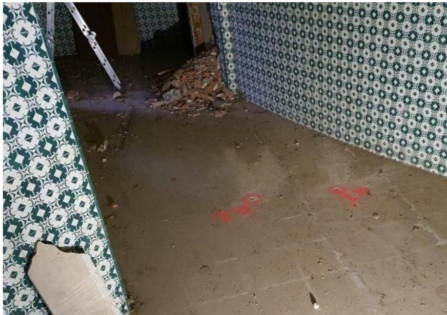
FOTO 16 – Taladros 7 y 8 realizados por INCOSUMA, para verificar la existencia de galerías bajo las eflorescencias.
