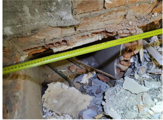
FOTOS 19 y 20 – Caracterización de las galerías que se encuentran por debajo de la solera de la platea
