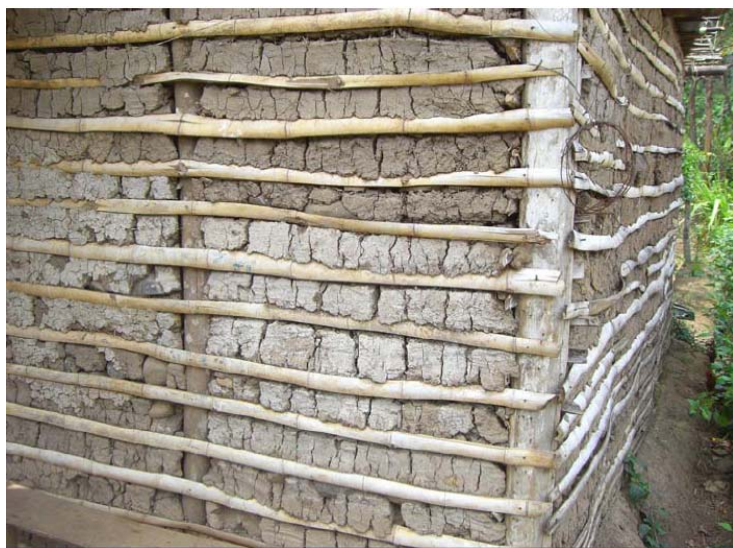
Detalle muro de bahareque.
