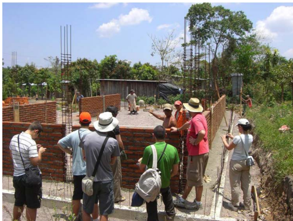
Todas las varillas verticales han de quedar ancladas a la cimentación.
