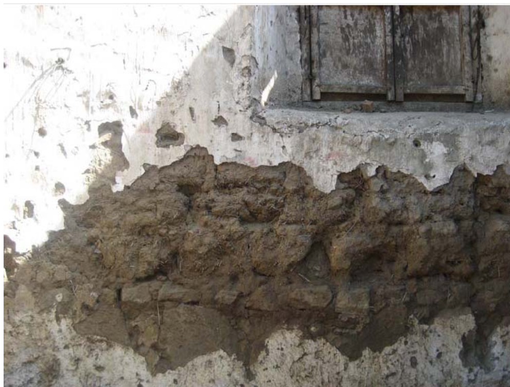
Ausencia de revestimiento por falta de mantenimiento.
