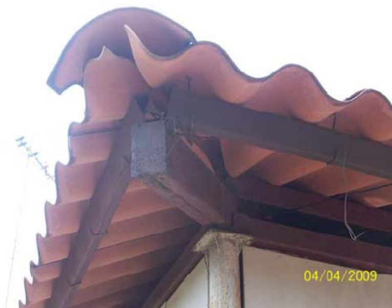
Alero cubierta fibrocemento
