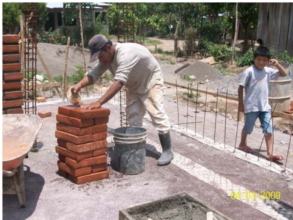
Todas las varillas verticales han de quedar ancladas a la cimentación.
