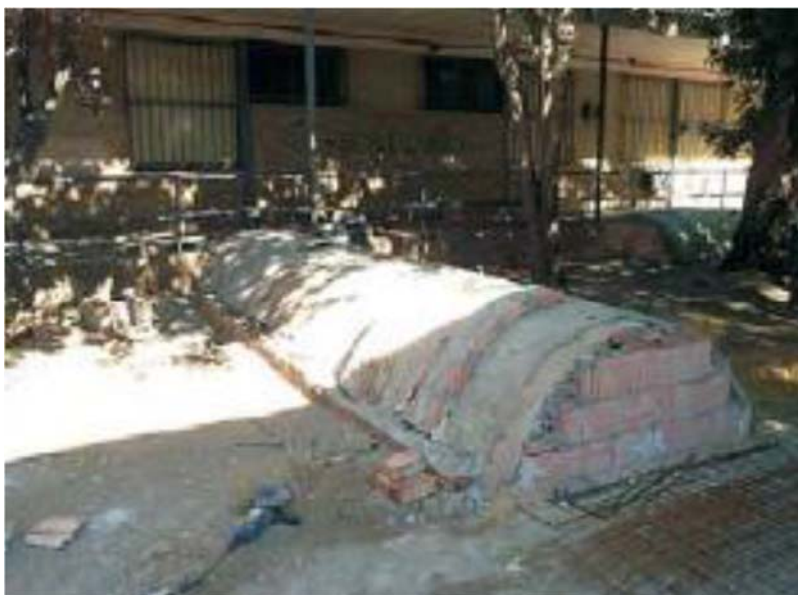
Construcción de encofrado con ladrillos
