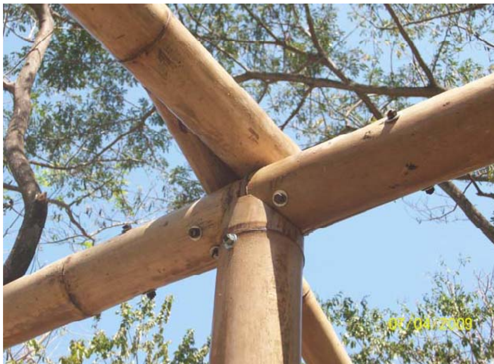
Detalle de unión de elementos verticales e inclinados
