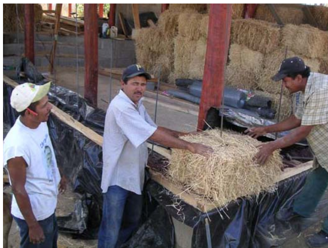
Impermeabilización primera hilada.
