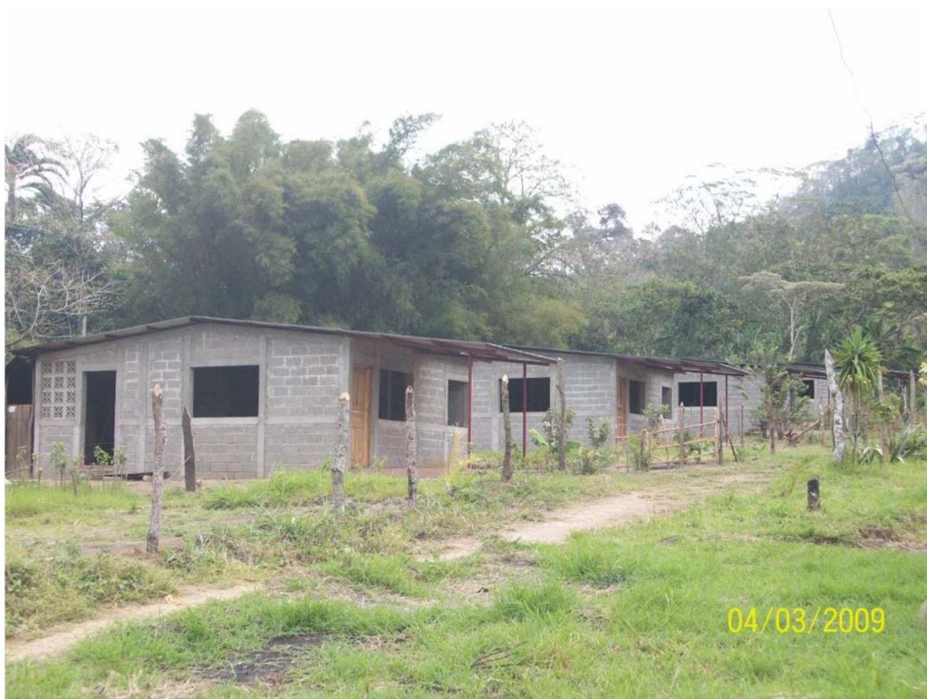
Viviendas con estructura de hormigón, cerramiento de bloques de hormigón y cubierta de zinc
