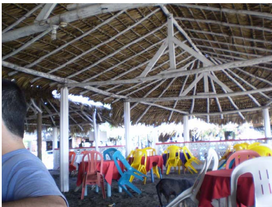
Cubierta con estructura de madera y cobertura de hojas de palma.
