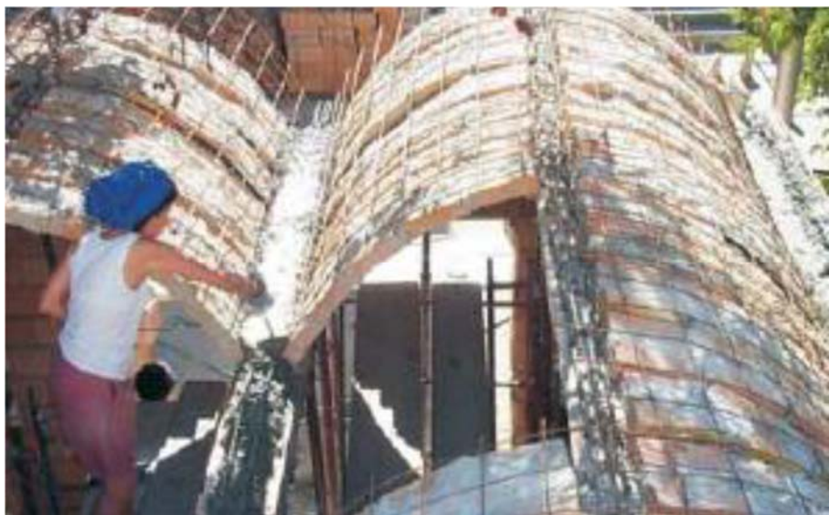
Colocación de dovelas y armadura de refuerzo
