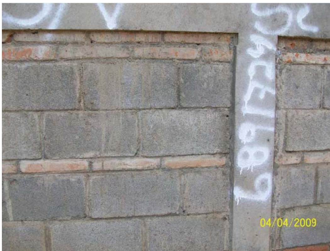
Las viviendas 11 y 12 muros de mampostería reforzada de bloque de concreto y bloque de barro y cubierta de teja de barro artesanal sobre estructura de madera.
