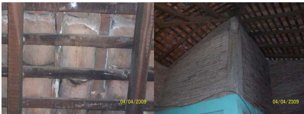
Estructuras de cubierta con correas, largueros de madera y teja árabe en Hospital España de Chinandega
