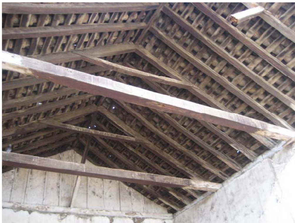
Cubierta de madera y tablero de caña.
