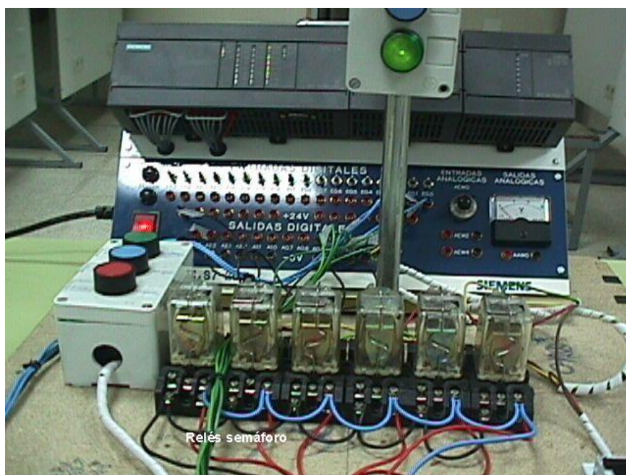
Práctica 1: detalle conexionado relés y autómatas
