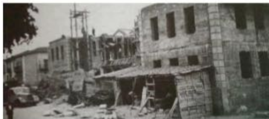
Obras en el edificio del Centro de Formación Profesional, donde estuvo la escuela.
