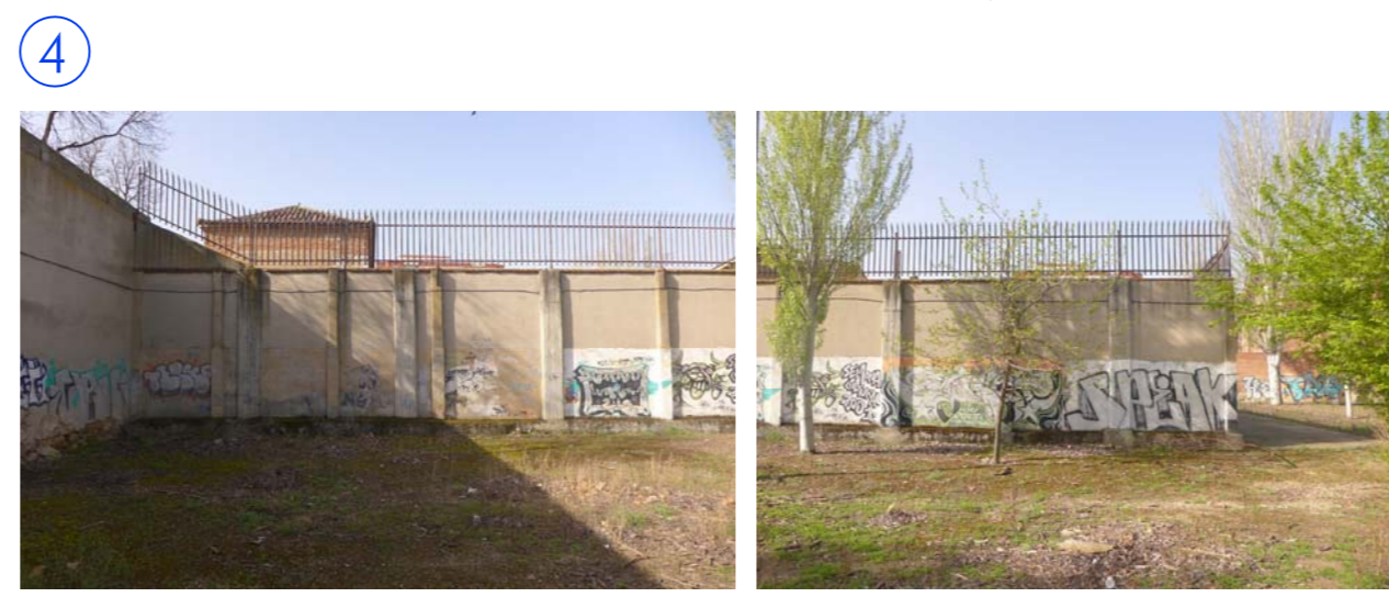
Muro ladrillo enfoscado
