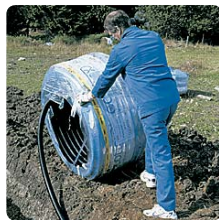
Se suministra a medida y se tiende directamente del rollo.
