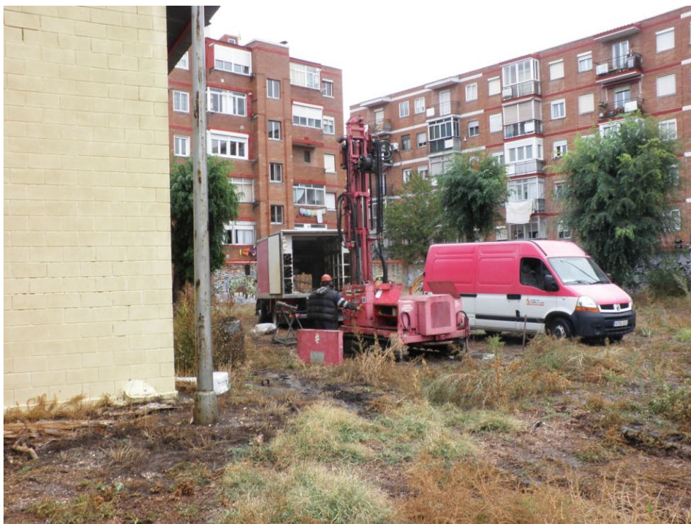
SONDEO MECÁNICO S-1. VISTA "D"
