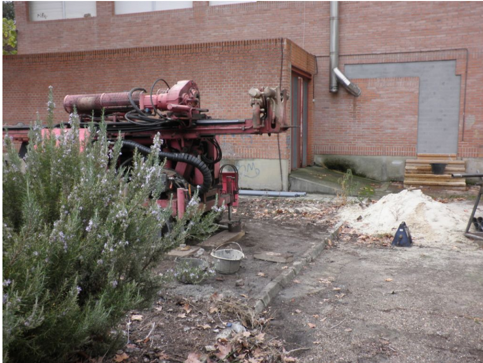
SONDEO MECÁNICO S-2 BIS.
