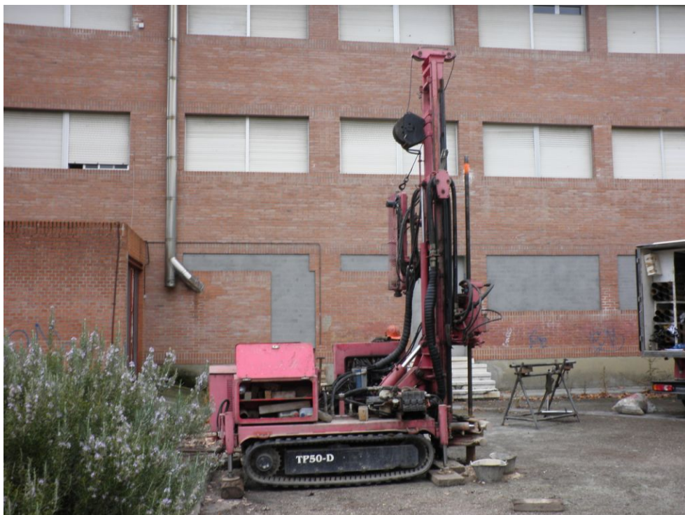
SONDEO MECÁNICO S-2. VISTA "C"
