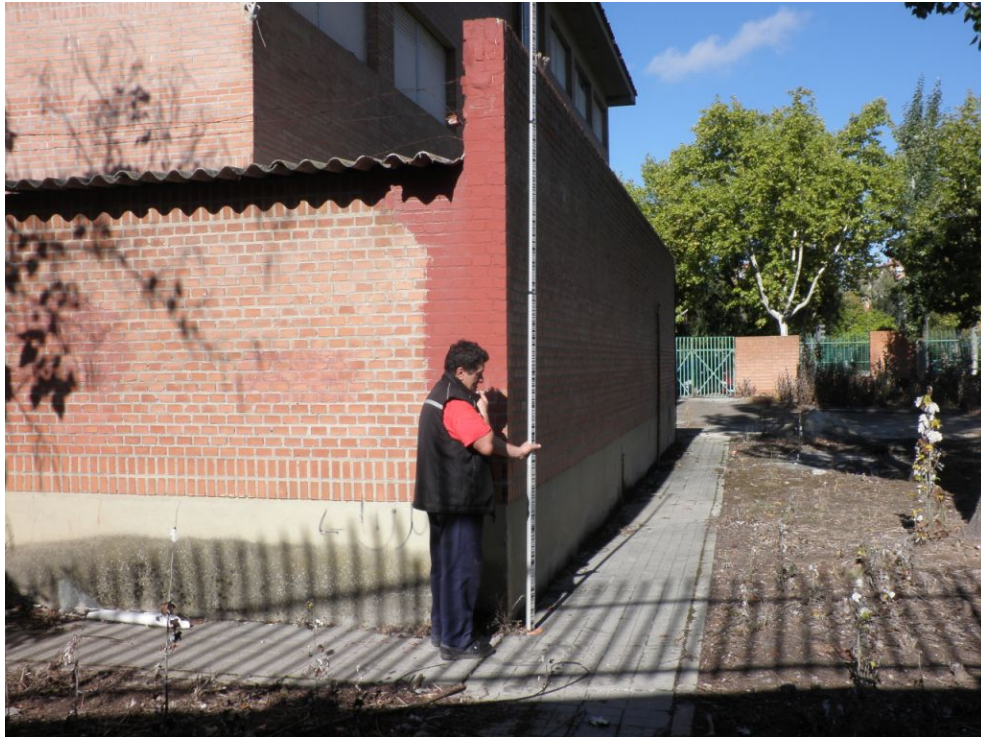
P.0 - BASE DE NIVELACIÓN
